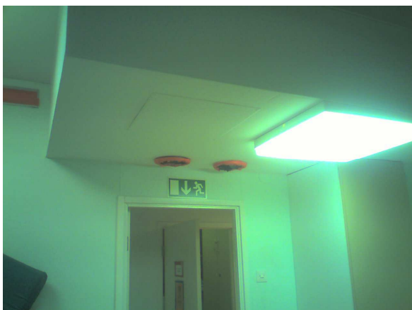
Kuvassa tiivistettyjä venttiilejä
