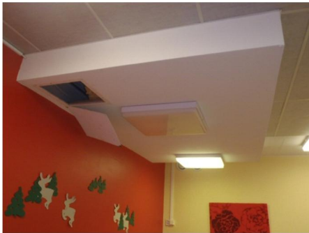
Kuva 21. Liikuntasalin kotelorakenne.
