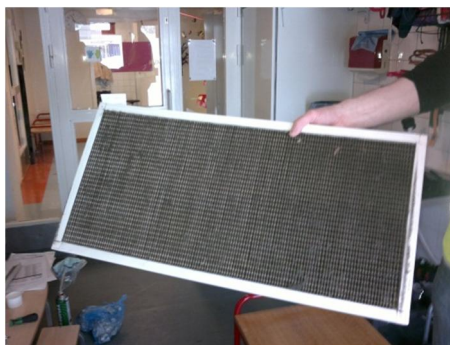
Kuva 26. TK11:n likainen suodatin.
