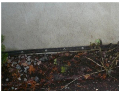
Kuva1. Sokkelielementin sauma on auki. Kuva 2. Patolevy on irronnut suojalistasta.
