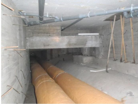
Kuva 11. Kaukolämpökanaali
