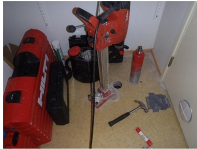
Kuva 5. Tuulettuvan alapohjan rakenneavaus.
