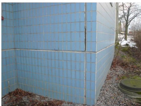
Kuva 14. Avonainen elementtisauma
