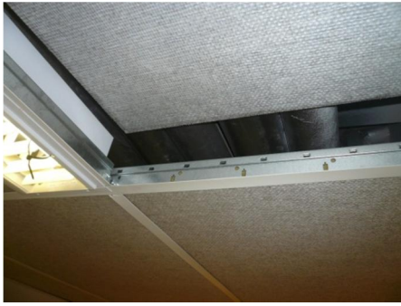
Kuva 17. Käytävän alakattorakenne.
