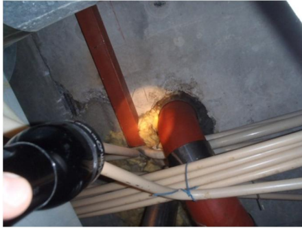
Kuva 20. Yläkerroksesta tuleva viemäriläpivienti.
