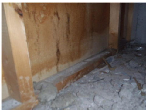
Kuva 15. Sisäverhouslevy palopostin alla. Kuva 16. Mikrobinäytteiden ottokohdat väliseinästä.
