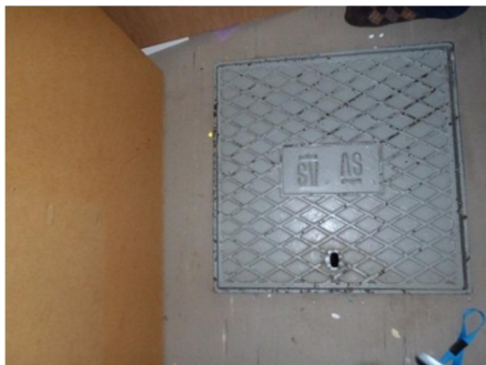
Kuva 8. Putkikanaalin tarkastusluukku
