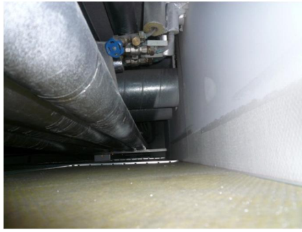
Kuva 18. Akustiikkalevyn pinnoittamaton yläpinta.
