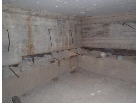
Kuva 12. Vanhaa muottilautoitusta kanaalissa.
