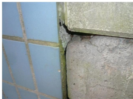
Kuva1. Sokkelielementin sauma on auki. Kuva 2. Patolevy on irronnut suojalistasta.
