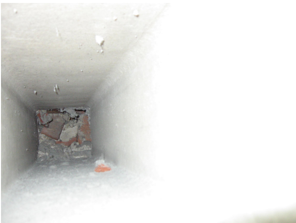
Kuva 15 1.krs. B-siipi wc 1 poistoilmakanava. (Mineriittikanavaa) Hormi romahtanut.
