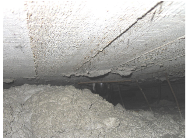
Kuva 34 1.krs. A-siipi. Runkokanavassa vesiputki ?
