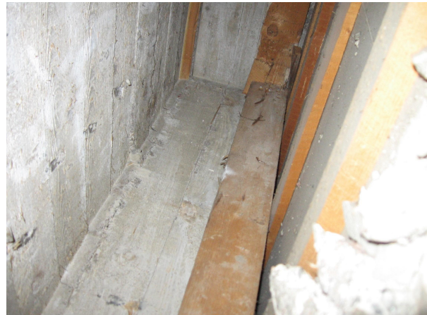
Kuva 8 2.krs. B-siipi. Huoneen 714 välitila venttiilin yläpuolelta kuvattu.
