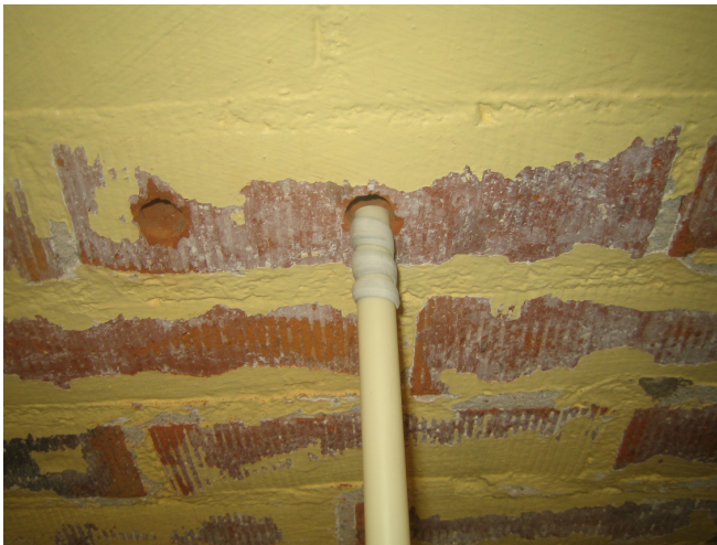
Kuva 9. Vantaan kaupungintalo, kellarikerroksen ulkoseinän suhteellisen kosteuden mittaus- mittausputkiin esiasennettiin tiivistyskitti siten, että mittausputki tiivistyi betonin sisäpin- nan bitumointiin tiiviisti putken asennuksen yhteydessä.
