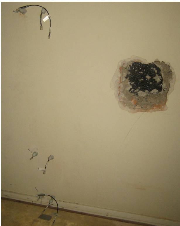
Kuva 15. Vantaan kaupungintalo, kellarin ulkoseinän mittauskohdassa KS4 sisäpuoleisen tiiliverhouksen ja kantavan betoniseinän välissä lämmöneristeenä on lastuvillalevy (ns. Tojax-levy).
