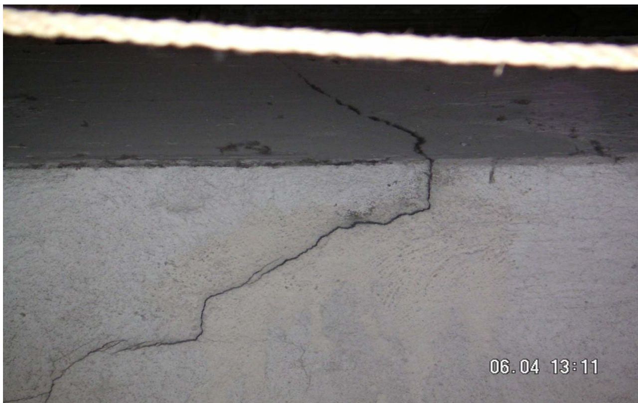
KUVA 4. Ullakolla olevaa rakenneaineista kanavaa, joka on halki.
