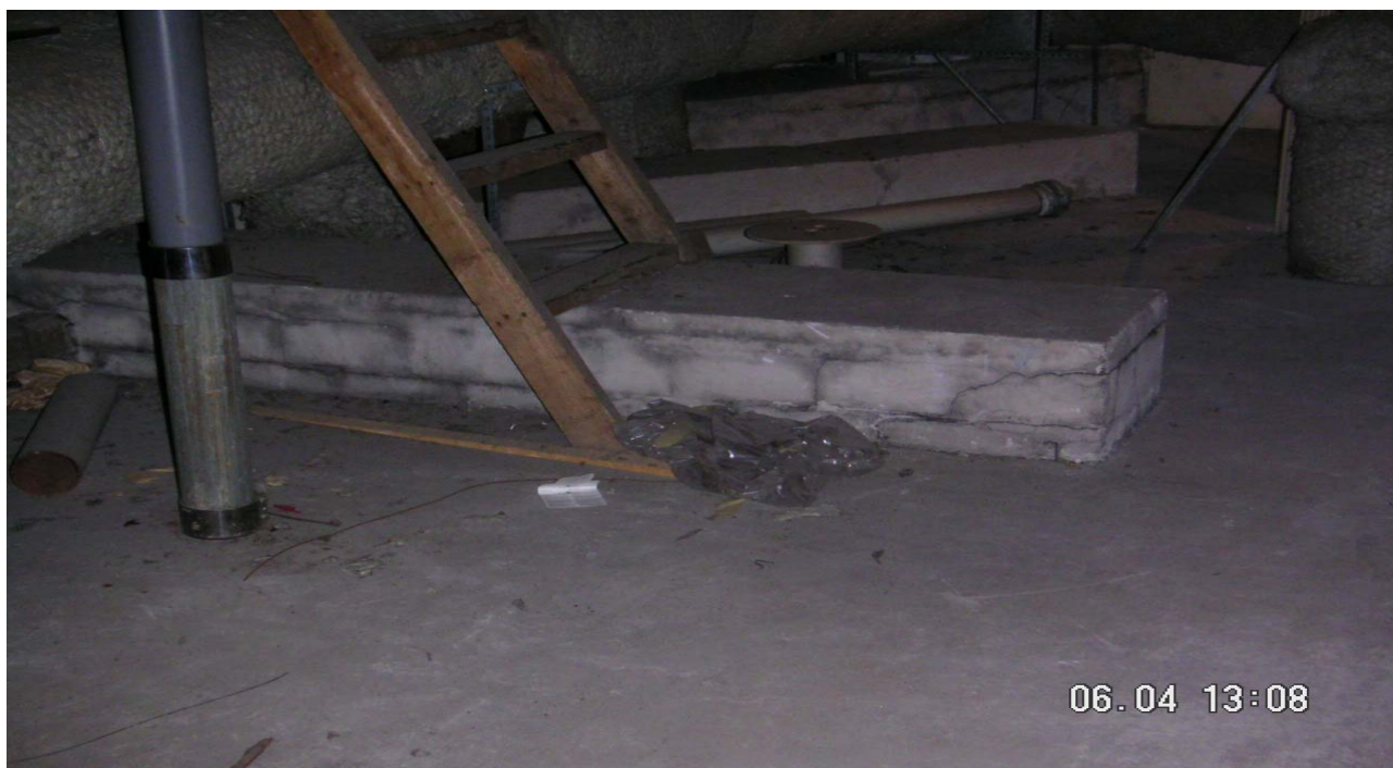
KUVA 2. Ullakolla oleva rakenneaineisen hormin yläosa.
