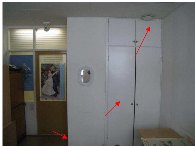
Kuva 22 Huoneen 651 tulee ilmaa kynnysraosta ja poistuu kattoventtiiliin.
