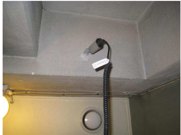
Kuva 16 Huoneen 615 alle tehtiin mittaus koteloon, tulos vastasi kuivaa rakennetta.
