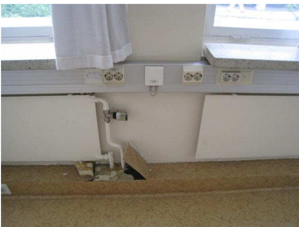
Kuva 11 Huoneen 615 betoninen asennuskotelo, johon tehtiin avaus.
