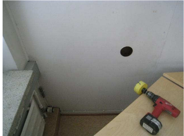
Kuva 28 Huoneen 651 rakenteita tutkittiin rasiapora-avauksin (välis. ja alakatto).
