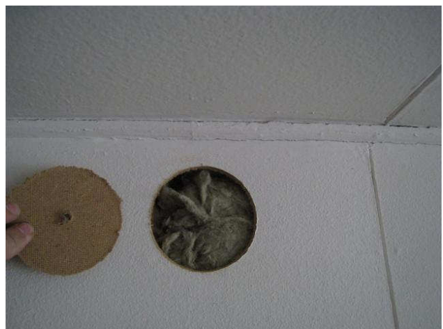
Kuva 30 H. 651 ja 650 välisessä seinässä on äänieristeenä mineraalivillaa.
