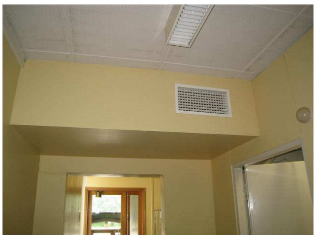
Kuva 24 Pohjoissiivessä korvaus-/ tuloilma on järjestetty koneellisesti käytäville.
