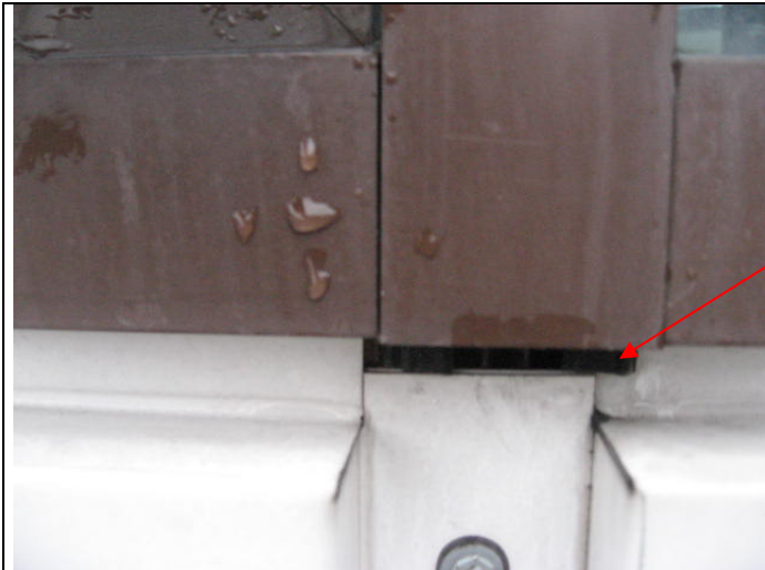
Kuva 1 Pelti liian lyhyt.
