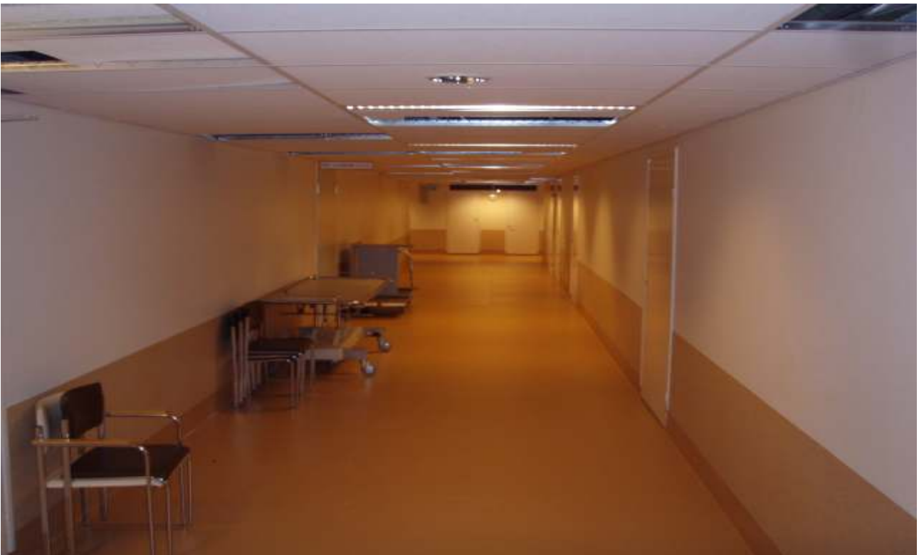
R-kuva 6. Kuva on pohjakerroksen käytävätilasta. Tilan pintarakenteet ovat tyydyttävässä kunnossa.
