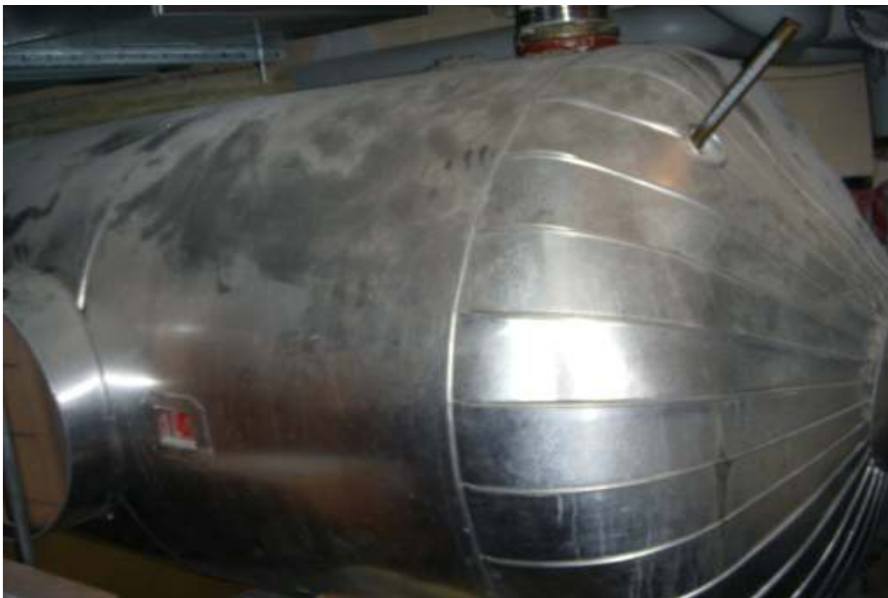
LVI-kuva 2. Käyttövesiverkoston varaajasäiliö.
