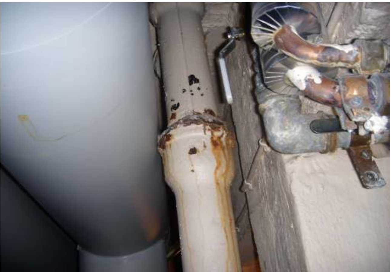
LVI-kuva 6. Yleiskuva viemärin ja käyttövesiverkoston nousulinjoista.
