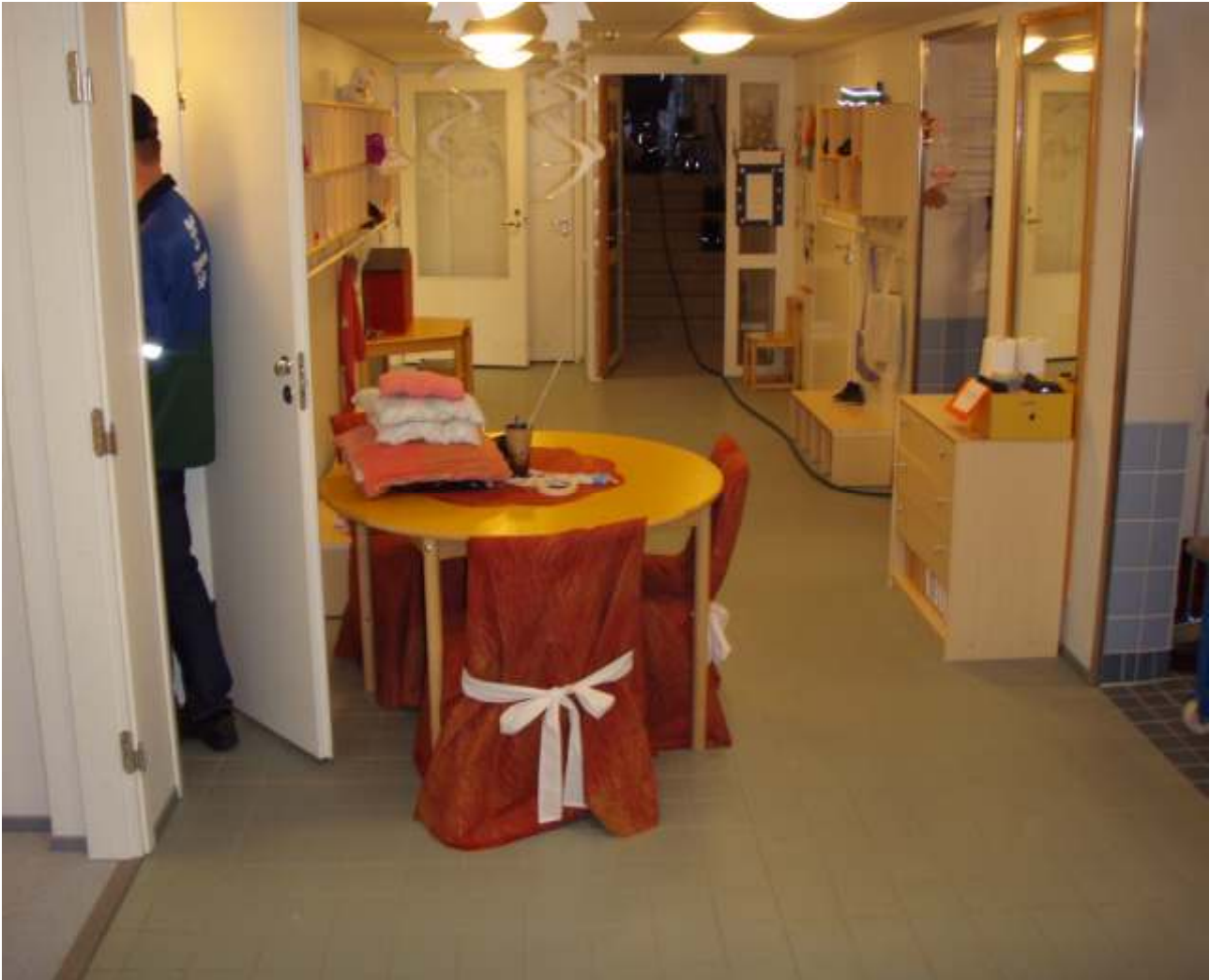
R-kuva 7. Päiväkotitilan 2002 kunnostetut pintarakenteet ovat tyydyttävässä kunnossa.
