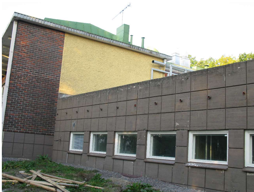
Kuva 1. Yleiskuva rakennuksen pääsisäänkäynnin osalta, sivu kaakkoon. Tällä osalla sisäänkäynnin yläpuolella parveke. Julkisivu koostuu neljästä eri materiaalista: rapattu tiili, slammattu tiili, puhtaaksi muurattu tiili sekä
