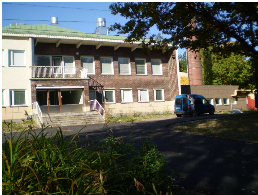
Kuva 1. Yleiskuva rakennuksen pääsisäänkäynnin osalta, sivu kaakkoon. Tällä osalla sisäänkäynnin yläpuolella parveke. Julkisivu koostuu neljästä eri materiaalista: rapattu tiili, slammattu tiili, puhtaaksi muurattu tiili sekä
