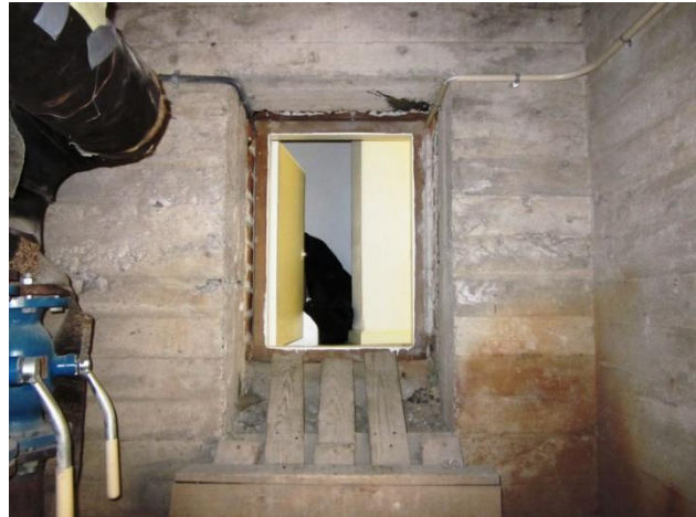
Kuva 2 Sisäänkäynti alustatilasta kuvattuna.
