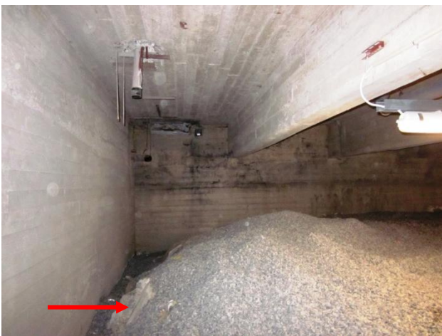
Kuva 3 Suodatinkangasta ja savea näkyvillä jyrkästä leikkauksesta johtuen.
