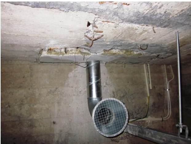
Kuva 6 Poistoilmakanavan pääte-elin.
