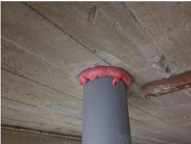
Kuva 10 Asianmukaisesti tiivistetty viemäriputken läpivienti.
