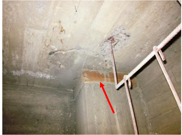
Kuva 13 Muottilaudoitusta jätetty paikoilleen.
