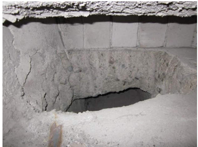
Kuva 15 Piikattu aukko takaseinustalla. Viistosti ylhäällä onkalo tv..
