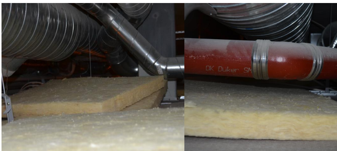
Kuva 15. C-, D- E- ja F-soluissa käytävien alaslaskettujen kattojen yläpuolella runsaasti avointa mineraalivillaa ja putkien päällä pölyä.
