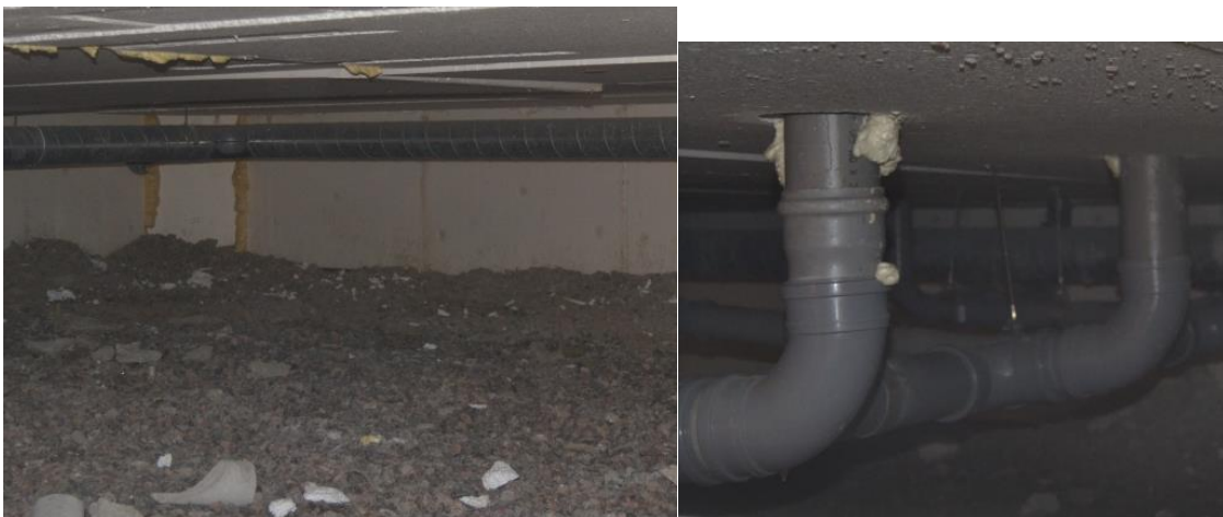
Kuva 4. E-solun alapohjatilassa ei havaittu puutteita (RH 60,6 %, 16,5°C). Viemärläpiviennit oli tiivistetty polyuretaanivaahdolla.
