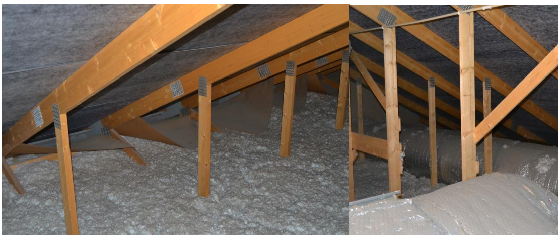
Kuva 20. Kaikkien solujen yläpohjatiloissa oli eristeenä puhallusvillaa. Runkopuissa, eikä muissakaan rakenteissa havaittu kosteuden aiheuttamia jälkiä. Runkopuiden kosteuspitoisuutta mitattiin pistokokeenomaisesti. Puurakenteissa ei mitattu kohonneita kosteuspitoisuuksia (9,5-13,8 paino%). Ilman suhteellinen kosteus vaihteli yläpohjatiloissa 71-78% ja lämpötila -0,9...-3,3°C (ulkoilma RH 78 %, -3,1°C).
