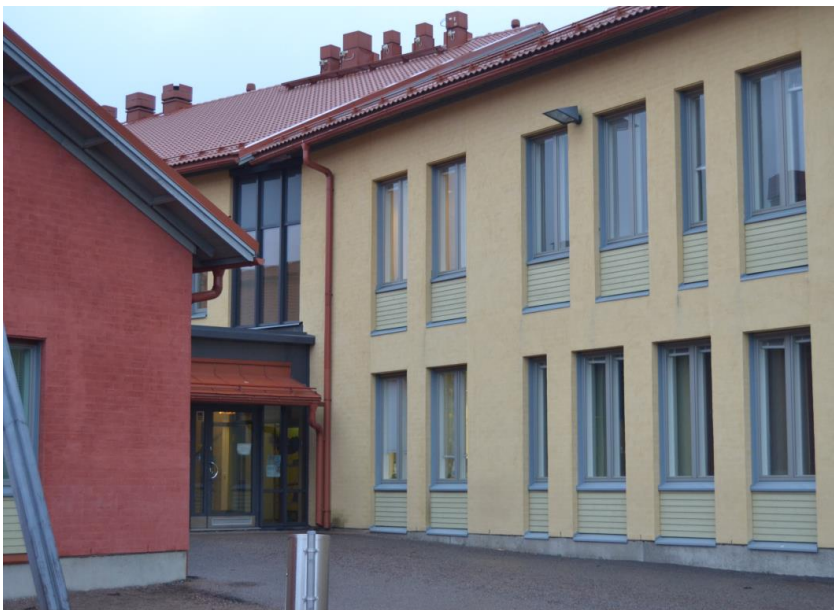
Kuva 13. D-siiven juuressa lattiantaso lähellä ulkopoulisen maanpinnan tasoa. Luokissa 1168 ja 1169 (1. krs ikkunat) ei havaittu lattiapinnoilla kohonneita kosteusarvoja pintakosteusilmaisimella havainnoitaessa. Vasemmalla päiväkoti.
