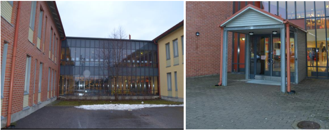
Kuva 9. Koulurakennuksen piha-alueet on sisäpihojen puolella pääsääntöisesti asfaltoitu ja Tilkuntien puolella laatoitettu. Syöksytörvien alla on sadevesiviemärikaivot. Katetulla piha-alueella on sadevesikaivot.
