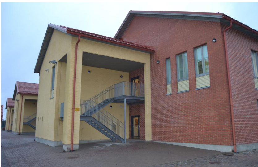
Kuva 12. Rakennuksen julkisivun tiilimuuraus oli Tilkuntien puoleisella seinustoilla jätetty rappaamatta ja pihan puoleisilla seinustoilla rapattu (US1). Ikkunoiden alapuoella laudoitus (US2). Ulkoseinärakenteissa ei havaittu puutteita.
