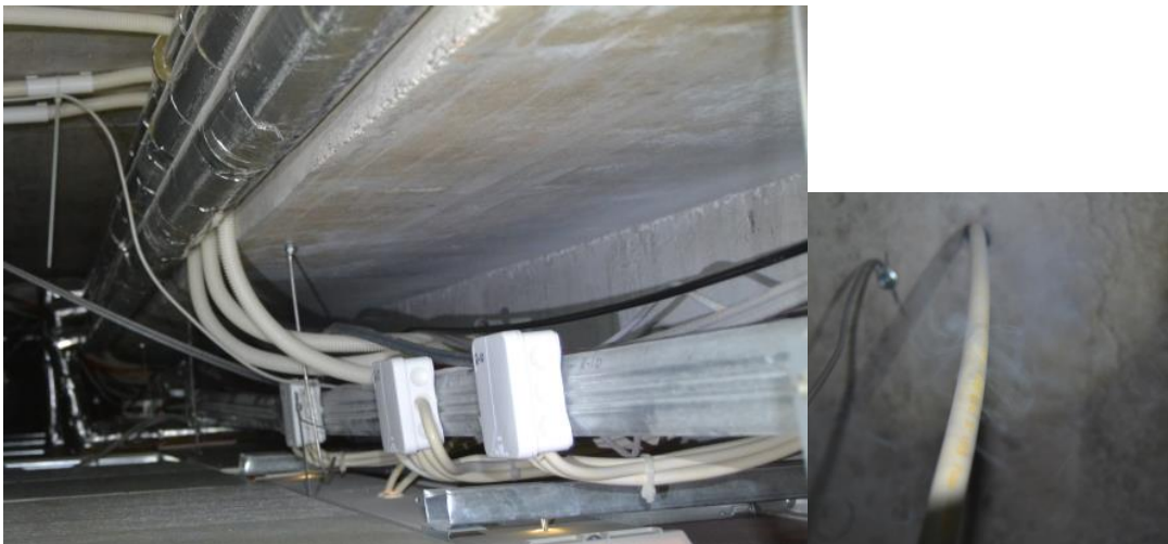
Kuva 17. H- ja I-soluissa alaslaskettujen kattojen yläpuolet siistit. Yläpohjan läpiviennistä ei havaittu ilmavirtauksia kumpaankaan suuntaan (merkkikaasu ei liikkunut).
