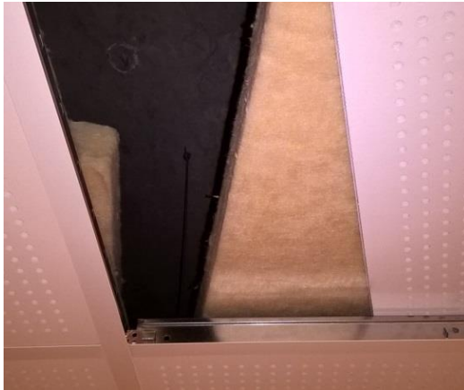
Kuva 4. D-solu 2 krs mineraalivillalevyt olivat poistamatta
