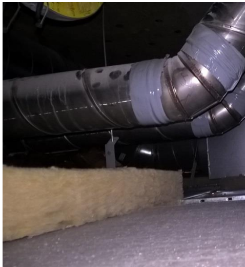
Kuva 6. F-solu 2 krs: mineraalivillalevyt poistamatta, vähäinen määrä pölyä. IV-kanavat pölyiset.
