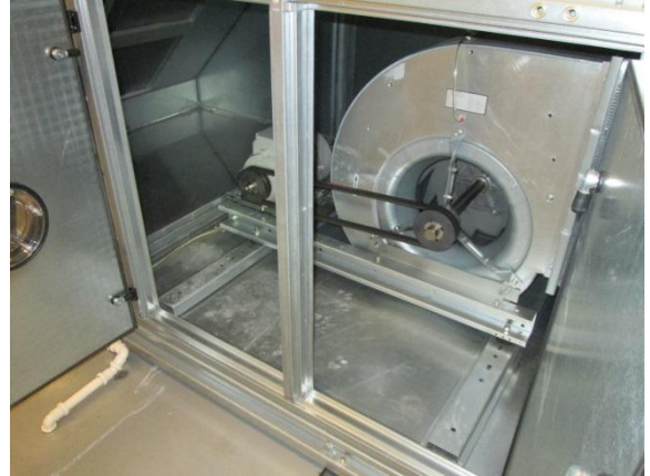
Kuva 3. Puhallinkammio puhaltimieen.
