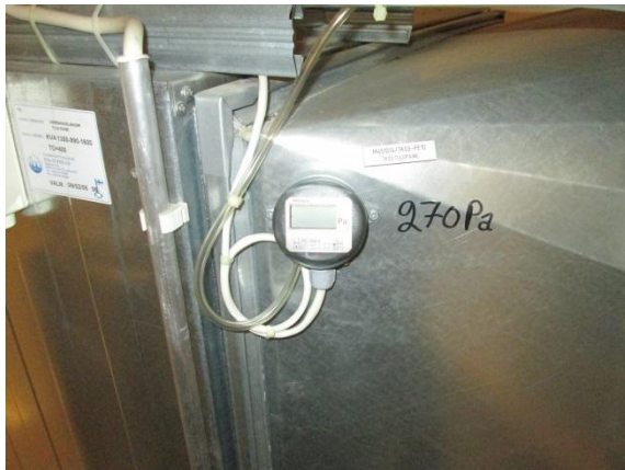
Kuva 4. Rikkoontunut paine-erolähetin – tämän laitteen oma näyttökin on sammunut, joten vika on helposti havaittavissa.
