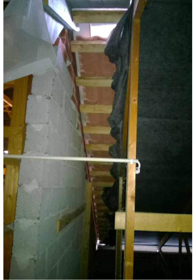
Kuva 14. Vesikatteessa aukko opetustilan 2091 kohdalla, ko. kohdassa ei aluskatetta.
