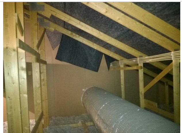
Kuva 14. Vesikatteessa aukko opetustilan 2091 kohdalla, ko. kohdassa ei aluskatetta.
