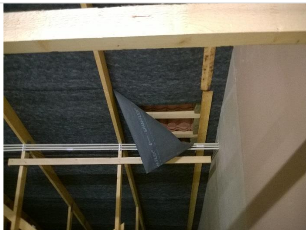
Kuvat 15 ja 16. Aluskatteen kiinnitys irronnut ja aluskatteet roikkuvat
