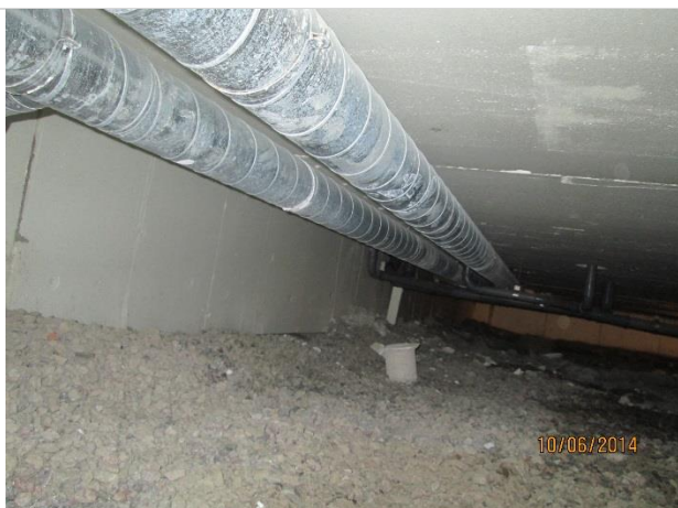
Kuva 10. Yleiskuva alapohjan tuulettuvasta tilasta.
