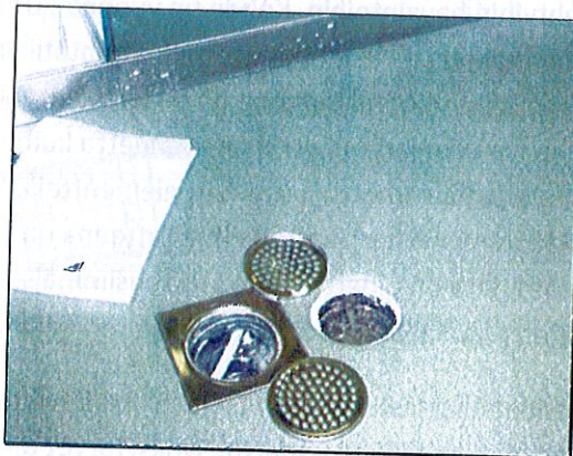
Kuva 2. Ruokalan linjaston lähellä sijaitsevat lattiakaivot.
