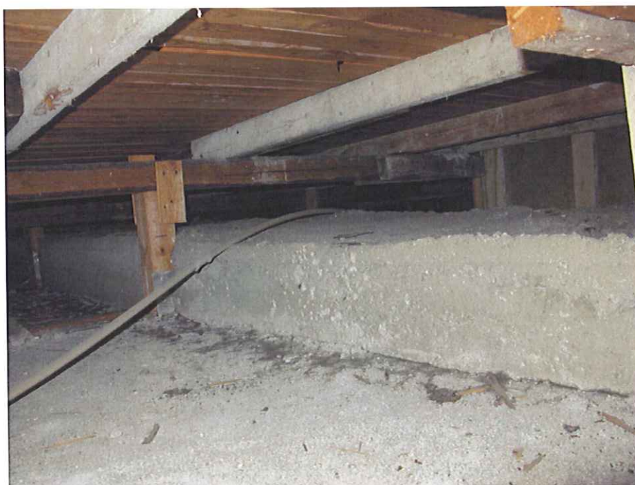
Kuva 8. Yläpohjan puurakenteet ovat rakennusajankohdan huomioiden kunnossa.
