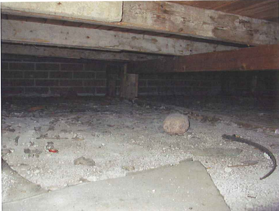
Kuva 9. Siporex-lankkujen pinnassa on noin 10 mm paksu laastitasaus. Yläpohjassa on jonkin verran sinne kuulumattomia roskia.
