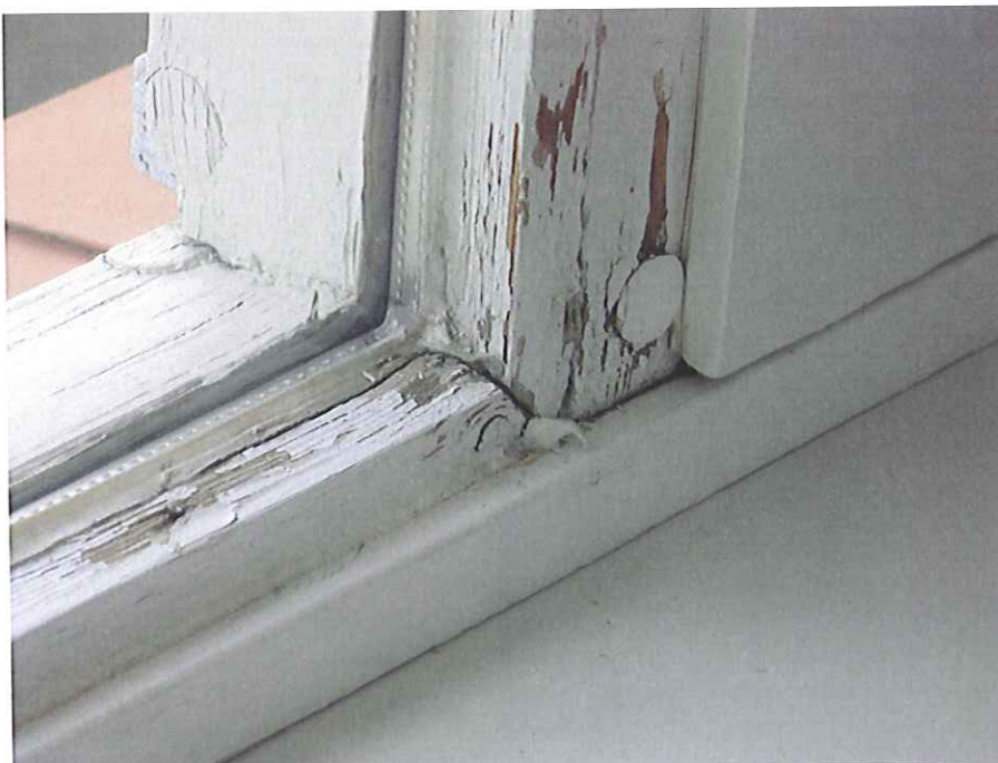
Kuva 16. Lounaissivulla Ikkunakarmien kunto oli pääosin välttävä. Puuosissa oli halkeamia ja puuaines oli pehmennyt. Puuosia on korjattu mm. elastisella kitillä
