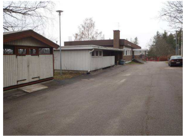
Kulkuväylät ovat pääosin tyydyttävässä kunnossa. Vedet ohjautuvat sadevesikaivoihin.
