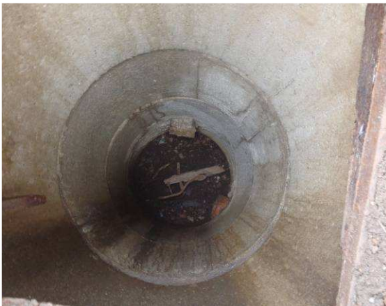
Kuvaa ylemmän kuvan salaojakaivosta. Salaojat ovat saviputkea, kaivossa ei havaittu vet-
