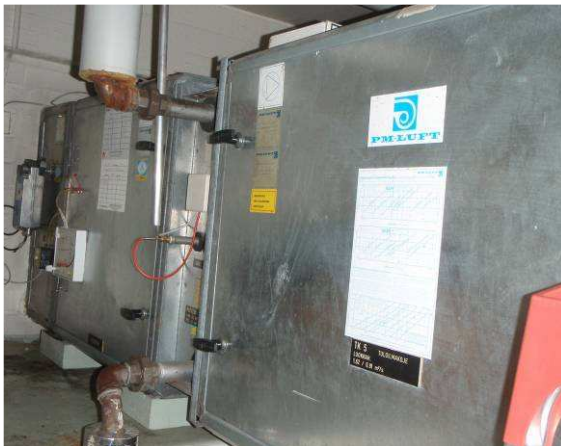
Ilmanvaihtojärjestelmän lämmityspatteristo
