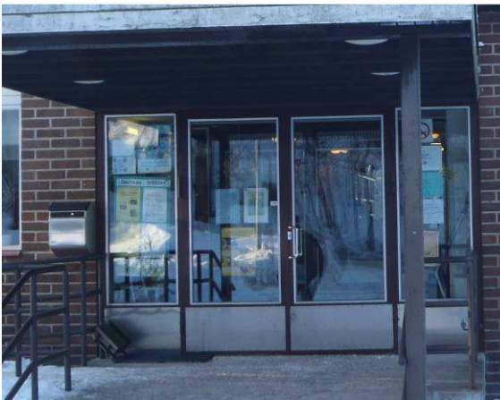
Pääovena on metallipariovi.
