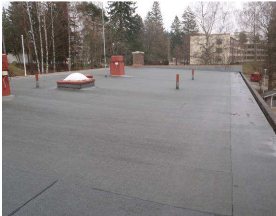
Vesikaton bitumikermi on uusittu 2000-luvulla ja se on vielä tyydyttävässä kunnossa.
