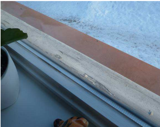
Kohteen ikkunat ovat kiinteitä puuikkunoita.
