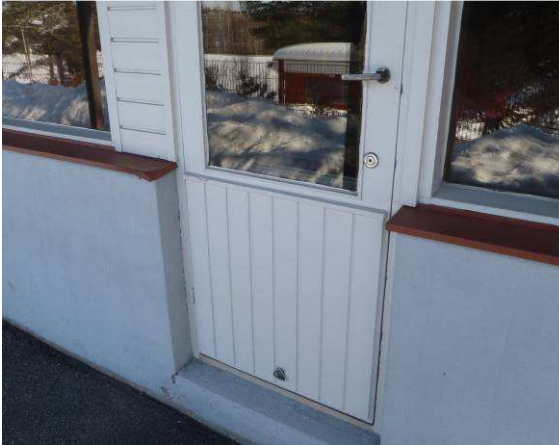
Sokkelipinnat ovat maalattuja ja vielä tyydyttävässä kunnossa.
