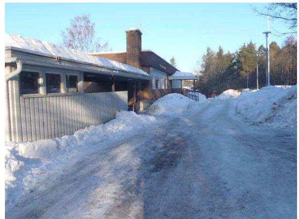
Rakennus on rinteessä ja maanpinnat kallistavat rakennuksen suuntaan etupihan puolella.
