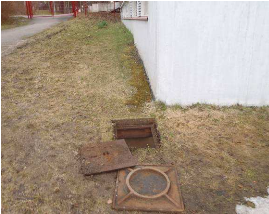
Etupihan puolella seinän vierustat ovat hienoa maa-ainesta. Sokkelissa havaittavissa musta patolevy. Nurkalla salaojakaivo.
