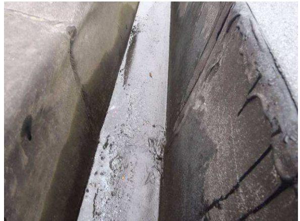
Vesikourut ovat vanhat, mutta vielä kunnossa.
