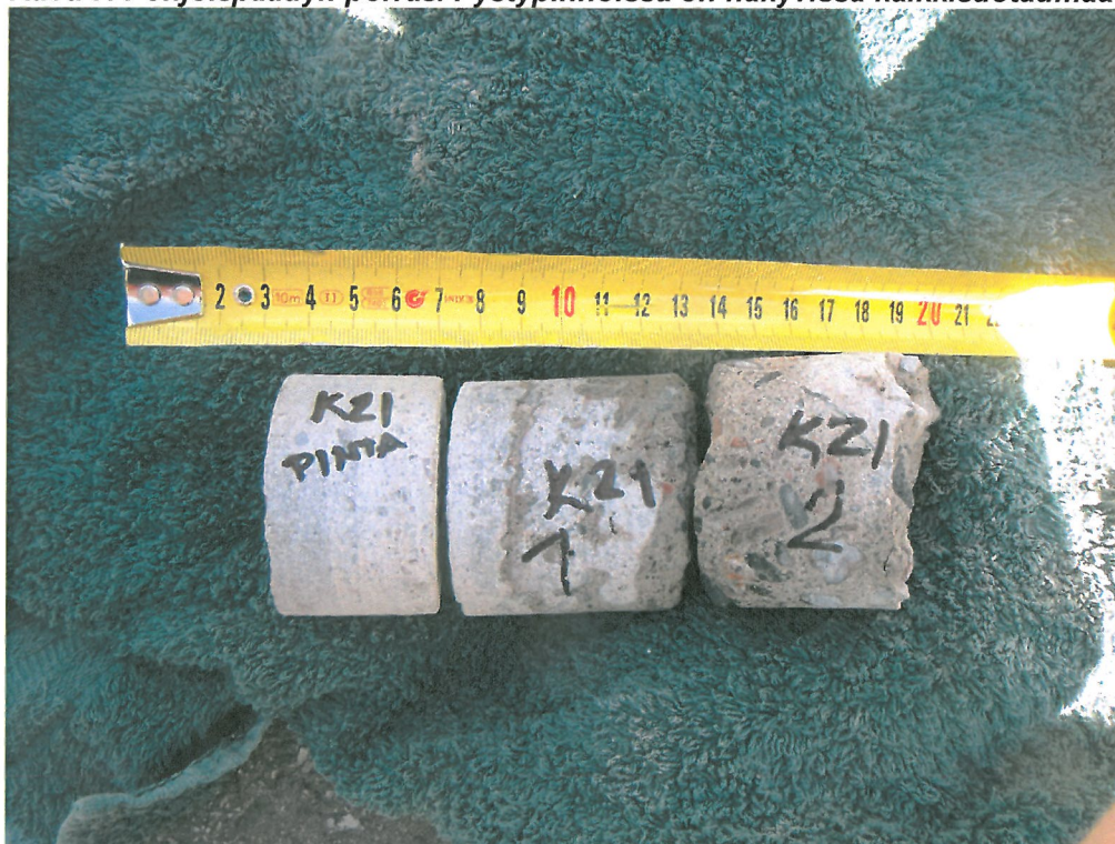
Kuva 8. Porrasnäyte K21. Pintalaatta irtosi kiinnityslaastin kohdalta porattaessa.
