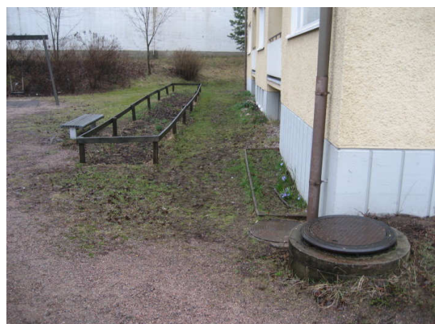
Kuva 2 Parvekesivulla multamaata vasten sokkelia. Kulmalla perusvesikaivo.
