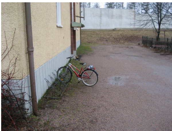
Kuva 1 Sisäänkäyntisivulla vesilätäköjä.
