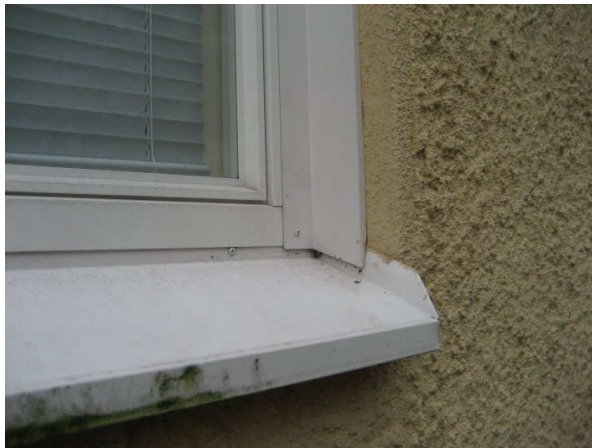
Kuva 5 Uusien ikkunoiden liittymät ovat tiiviit.
