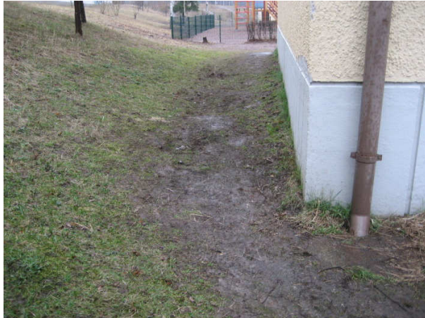
Kuva 3 Länsipäädyssä maa viettää kohti rakennusta. Kulmalla on rännikaivo.
