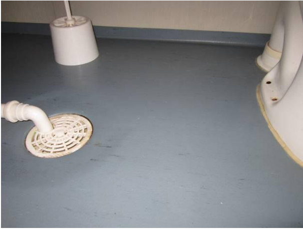
Kuva 33 Wc/ S muovikaivo ja wc-pytyn juuri-itiivistys.
