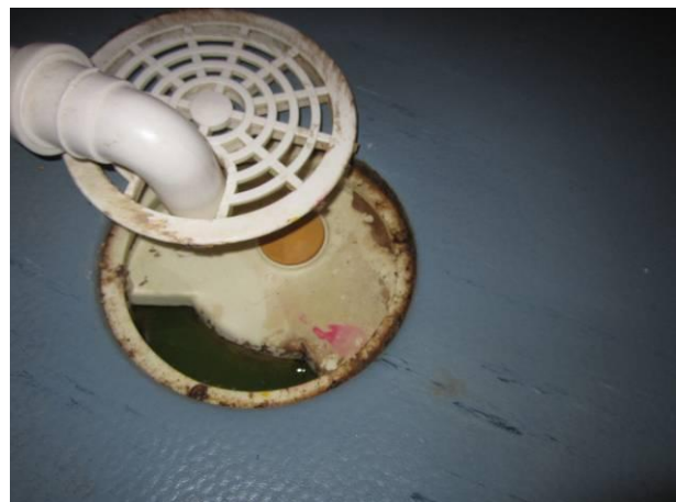
Kuva 44 Pesutiloissa lattiakaivot olivat muovia.
