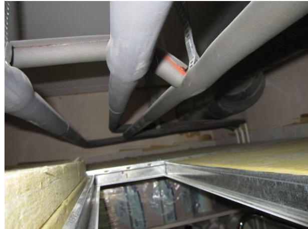
Kuva 42 Käyttövesiputkien runkolinja.
