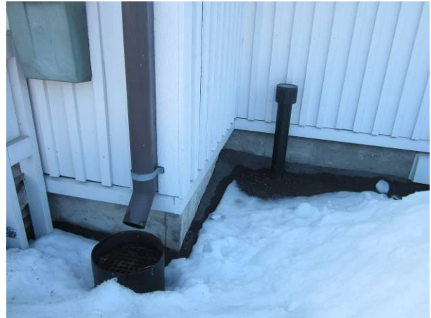
Kuva 6 Rännikaivo, sokkeliä vasten asfalttimakkara, alustatilan tuuletusputki.
