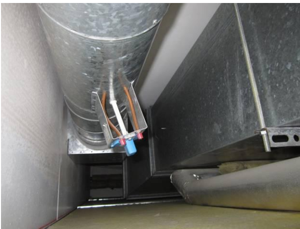
Kuva 39 Tuloilmakanava alakattotilassa
