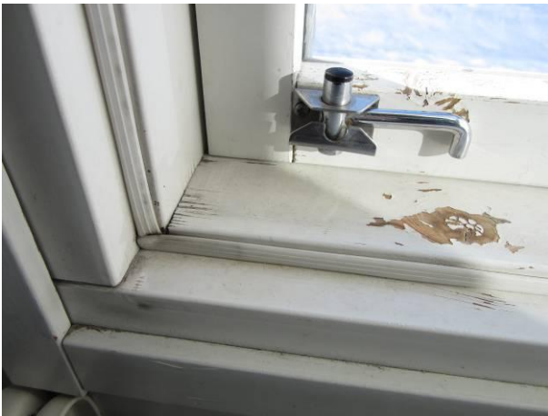
Kuva 15 Vesirasitusjälkiä.
