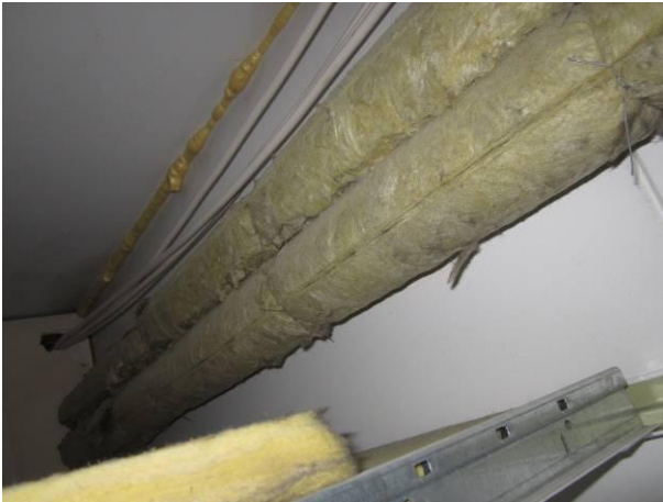
Kuva 41 Lämpöputkien runkolinja.
