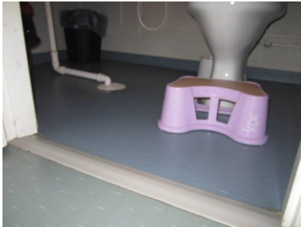
Kuva 9 Liian matala muovikynnys märkätilassa.
