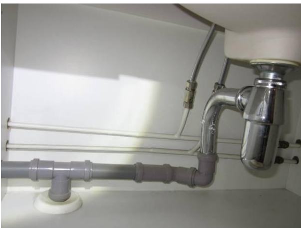
Kuva 43 Pesupaikan lavuaarikaapin asennuksia.
