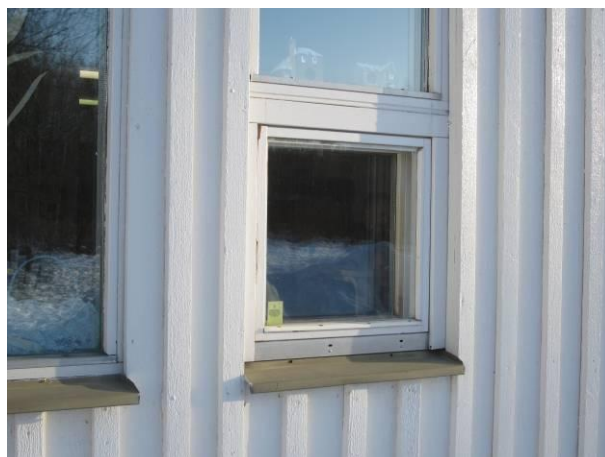
Kuva 13 Vesipellit ovat loivia.
