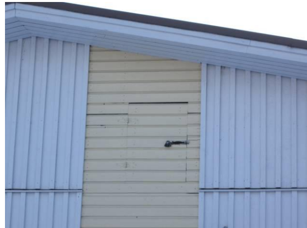
Kuva 12 Päätyseinä liikunta 30 -kohdalla, kulkuluukku yläpohjaonteloon.
