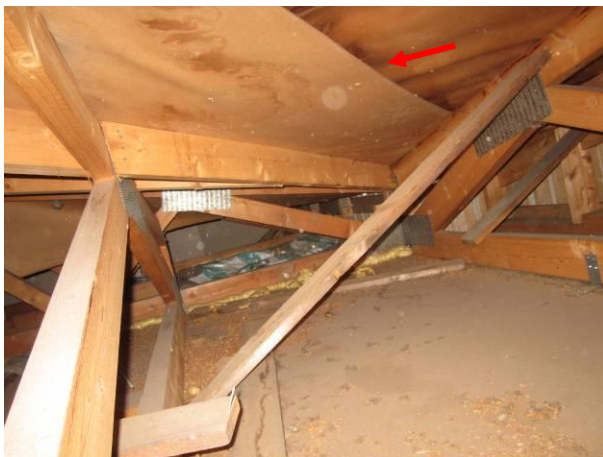
Kuva 25 Jiiritaitteen vuotojälkiä.
