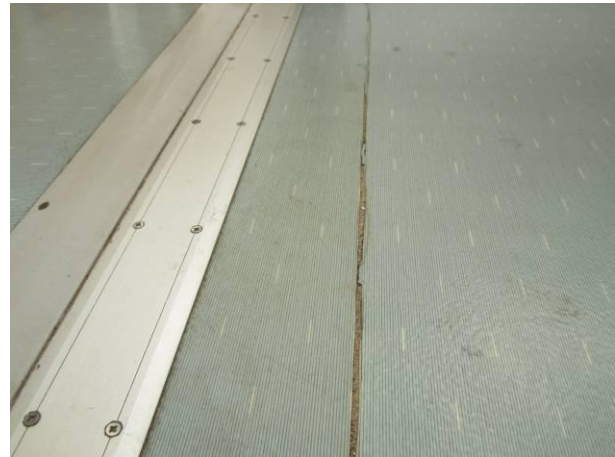
Kuva 10 Nivelosan maton halkeama työhön 31.
