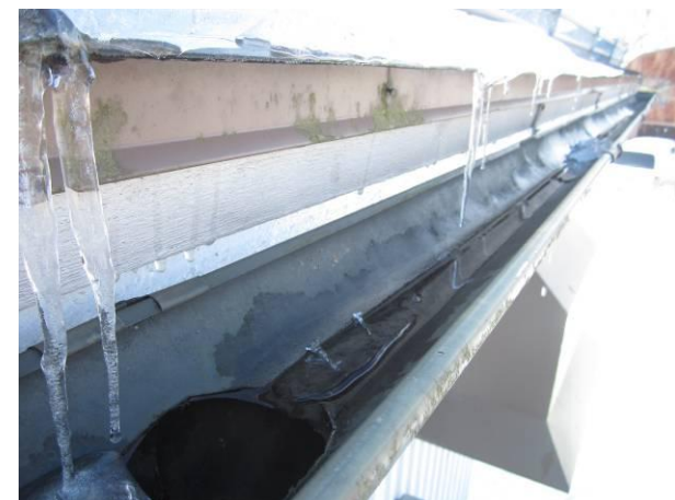
Kuva 22 Ränni ja ohivaluma
