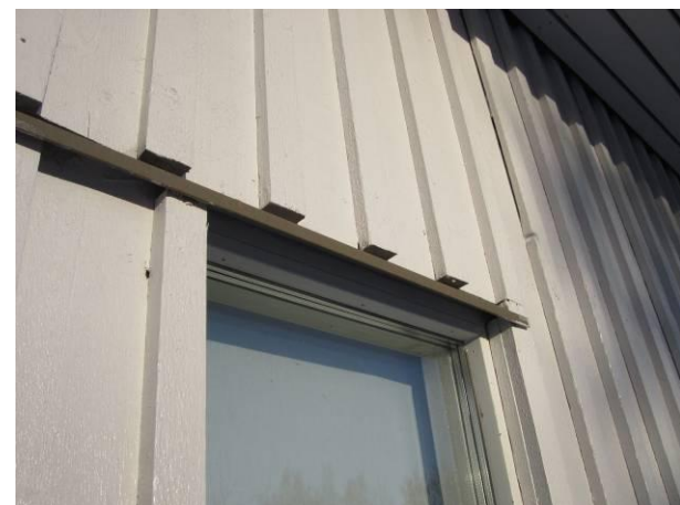
Kuva 14 Ikkunan yläpielen vesipelti.
