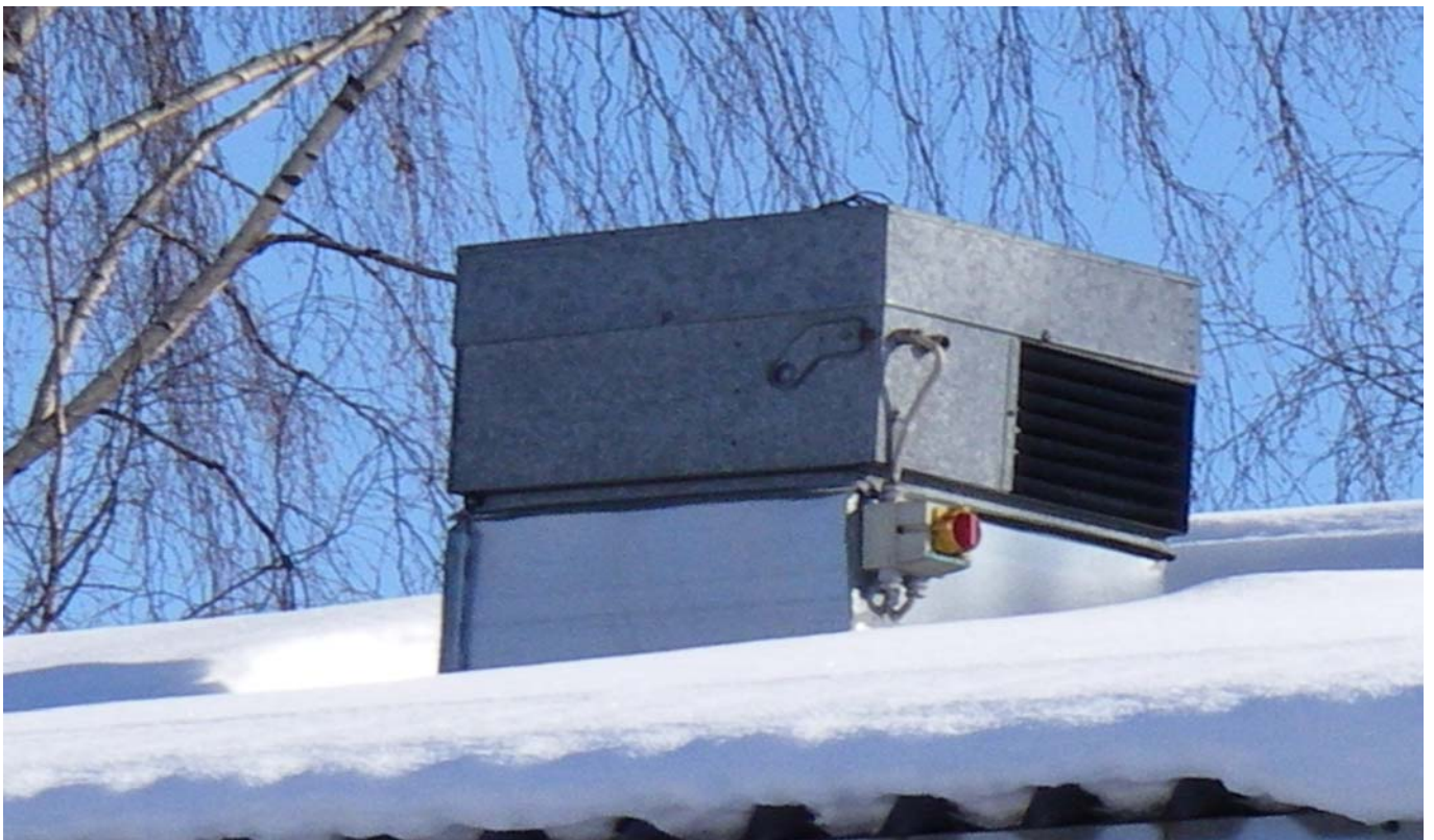
KUVA 6. Yleiskuva koulun vesikatolla olevasta huippuimurista.
