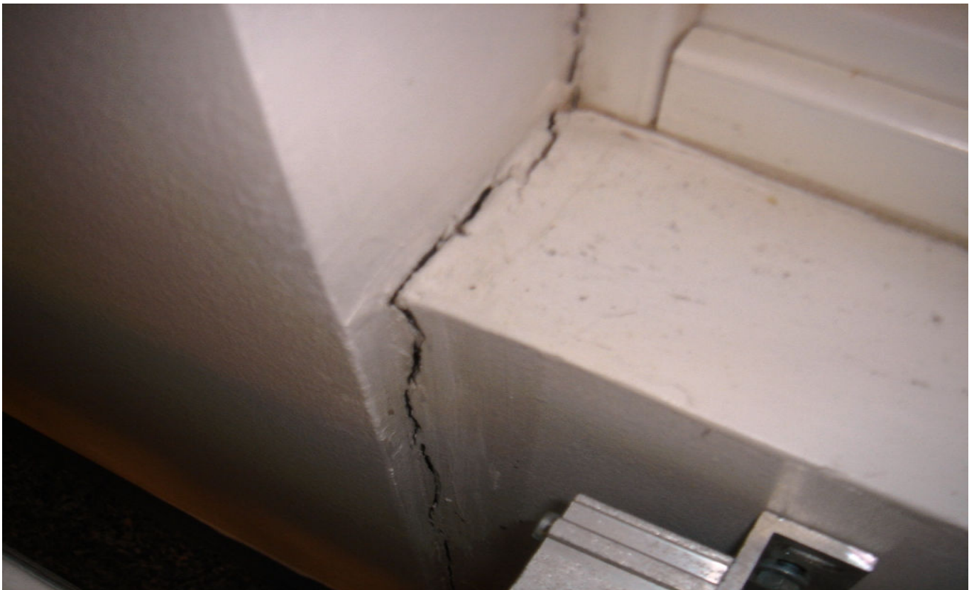
KUVA 34. Yleiskuva opetustilojen rakenteista.
