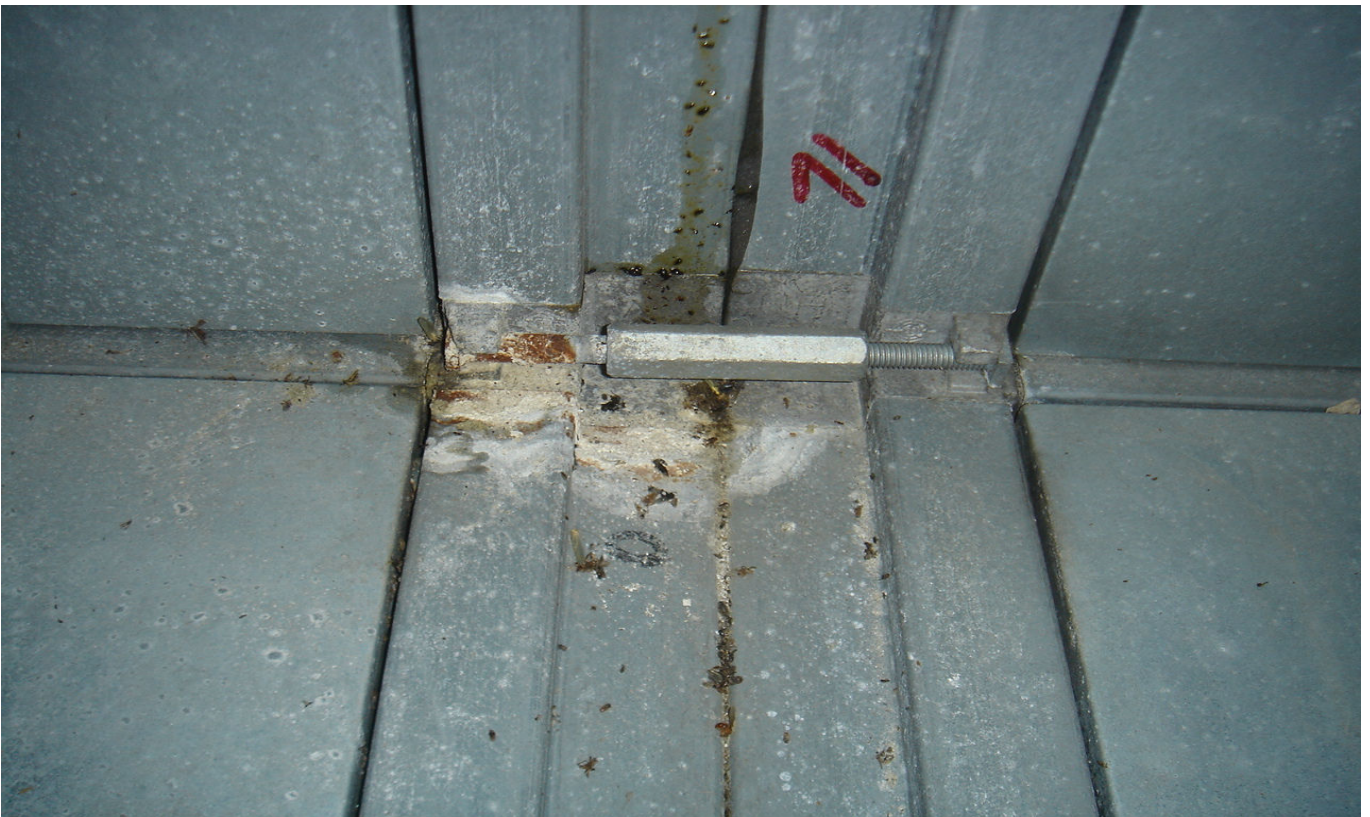
KUVA 12. Yleiskuva tuloilmakammiosta TK 04, TF 01.
