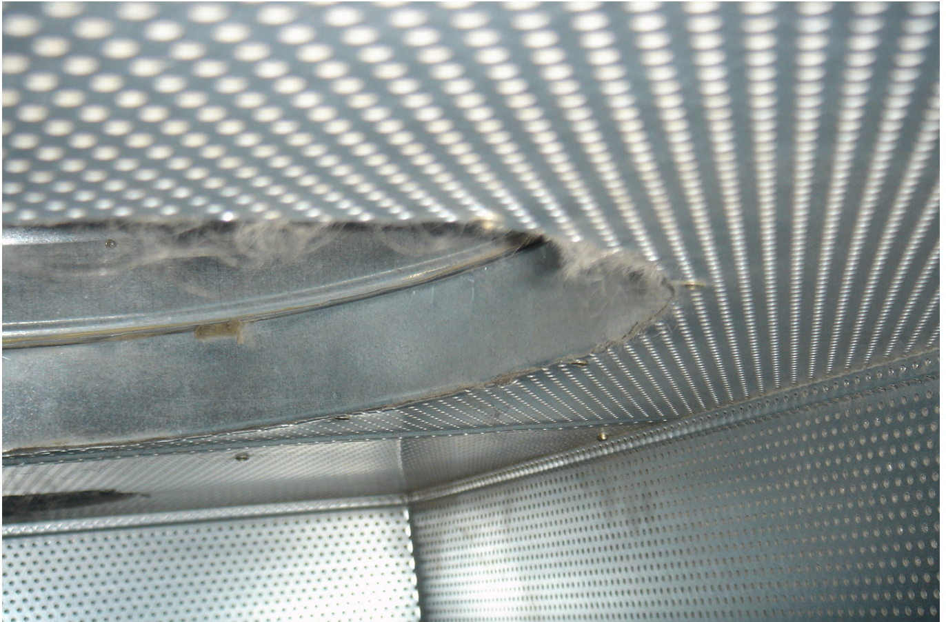
KUVA 13. Tuloilmakoneen kammiot on eristetty mineraalivillalla.
