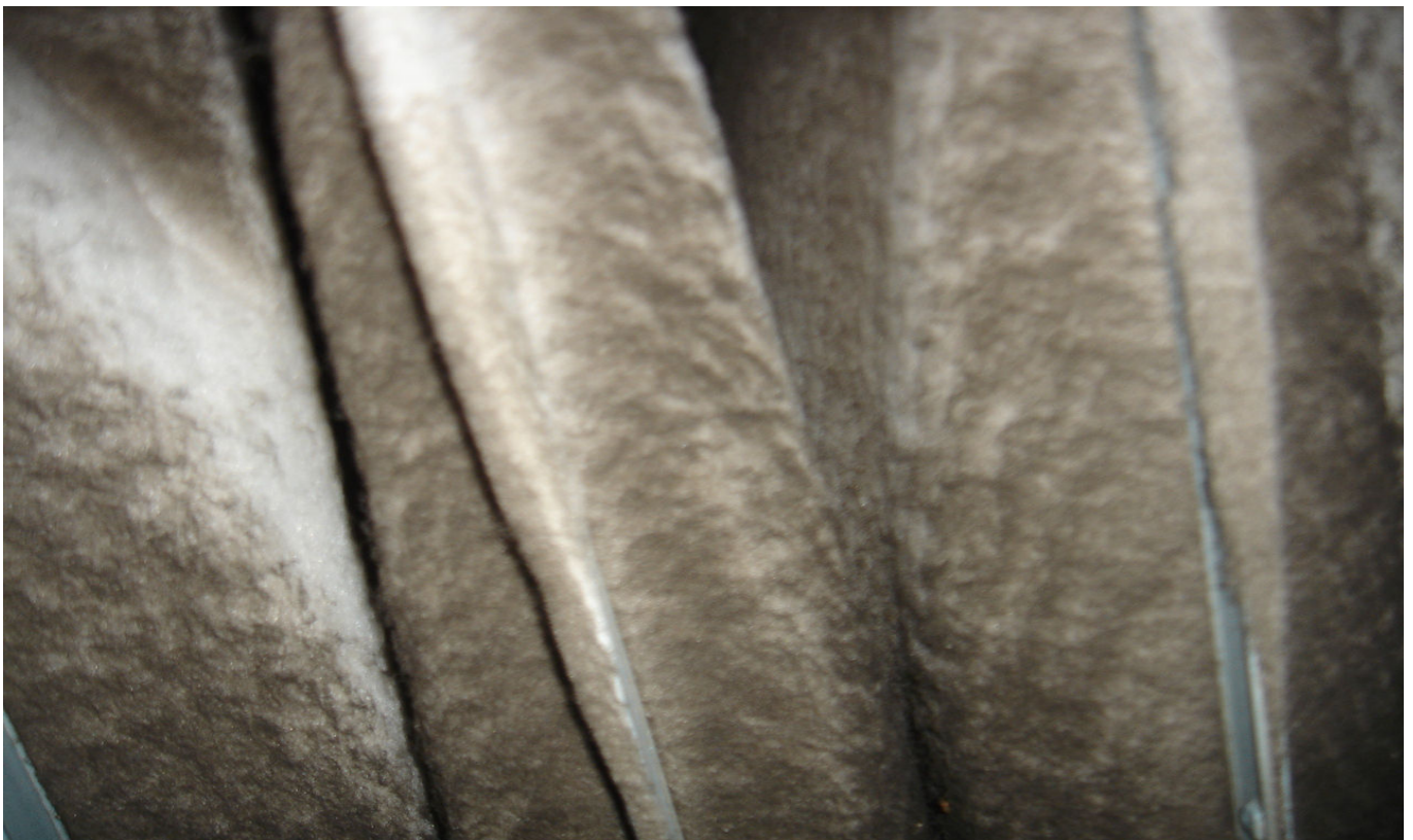
KUVA 14. Yleiskuva tuloilmalimasuodattimesta TK 06, TF 01.
