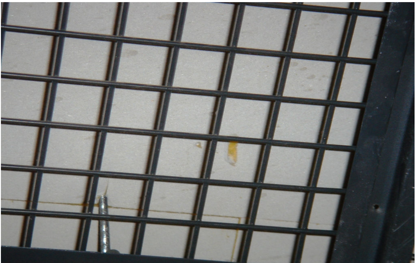
KUVA 28. Yleiskuva opetustilojen katosta.
