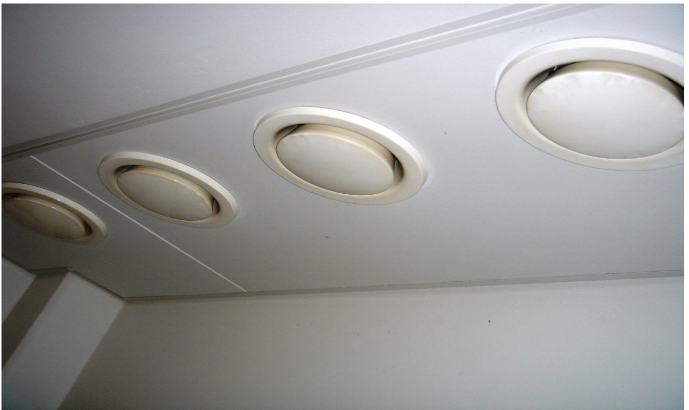
KUVA 26. Yleiskuva poistoilmaventtiilistä.
