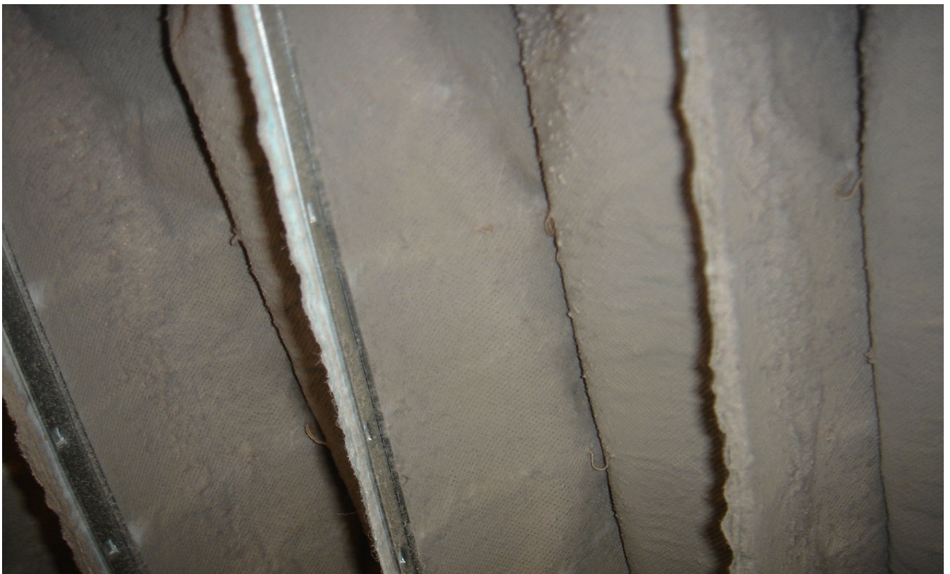
KUVA 16. Yleiskuva tuloilmailmasuodattimesta TK 07, TF 01.
