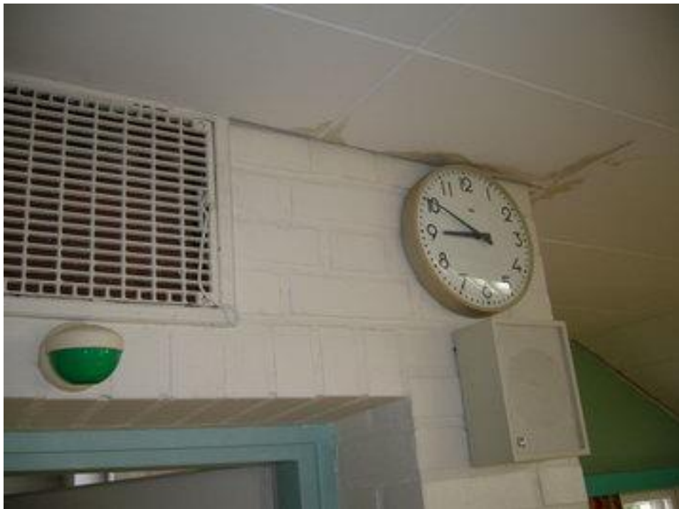
Rakennuksessa on aikakello-, turvavalo- ja kuulutusjärjestelmät.
