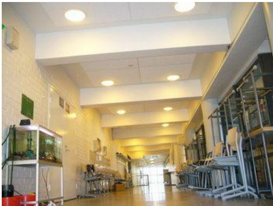
Ensimmäisen kerroksen käytävän valaistus on uusittu.
