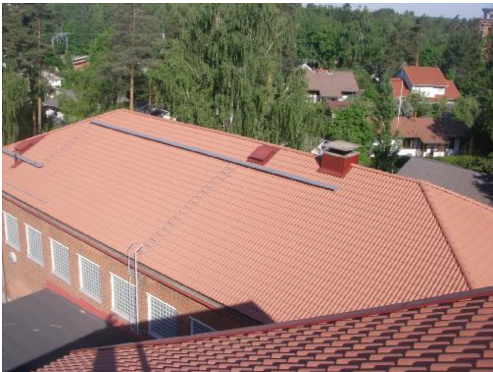
Näkymä vesikatolta. Vesikatteilla on vielä käyttöikää jäljellä.
