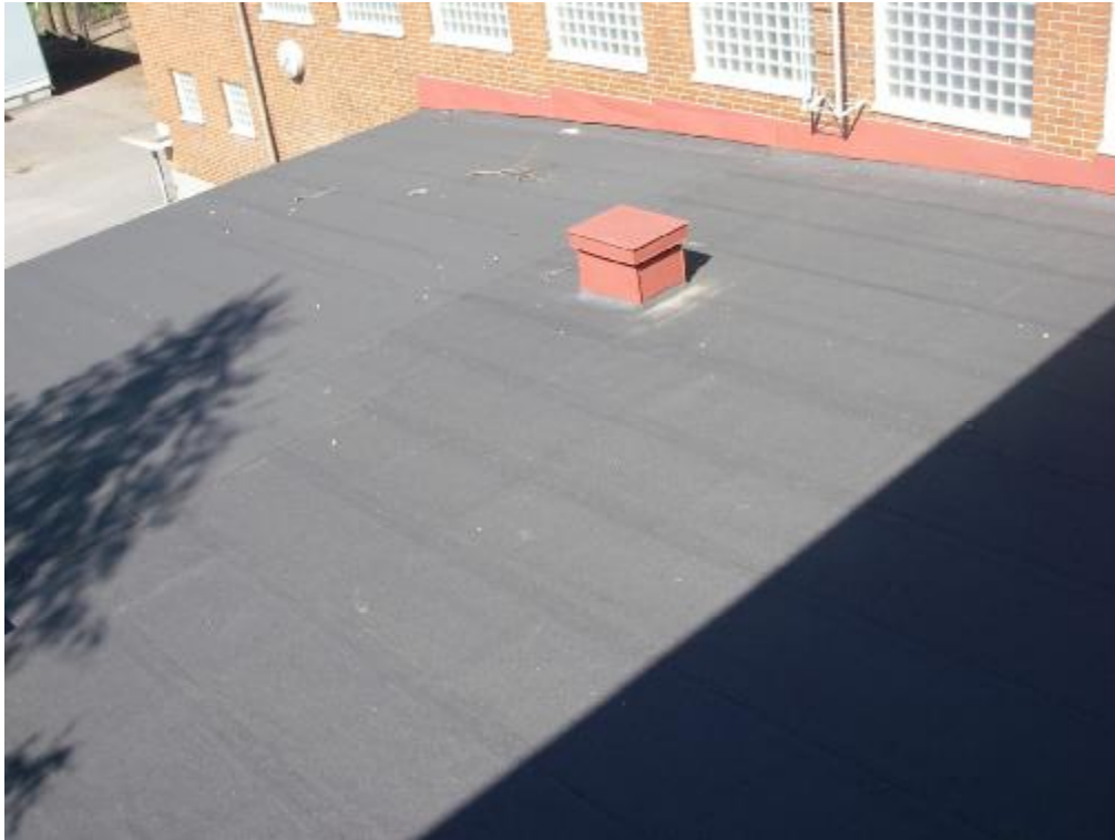
Myös väliosan bitumikate on silmämääräisesti tarkasteltuna kunnossa.
