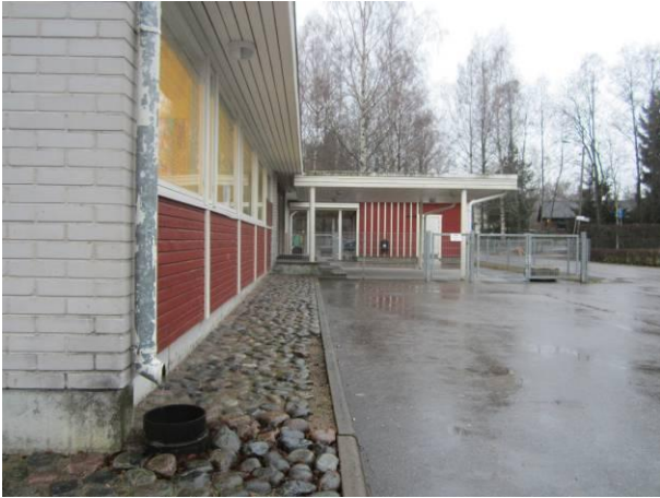
Kuva 9 Luoteissivulla kallistukset ovat riittävät.
