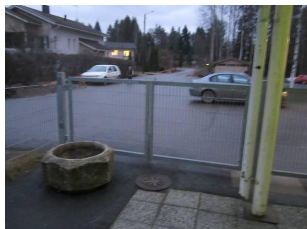
Kuva 14 Rännivedet valuvat katoksen toisella kulmalla rännikaivon ohi.
