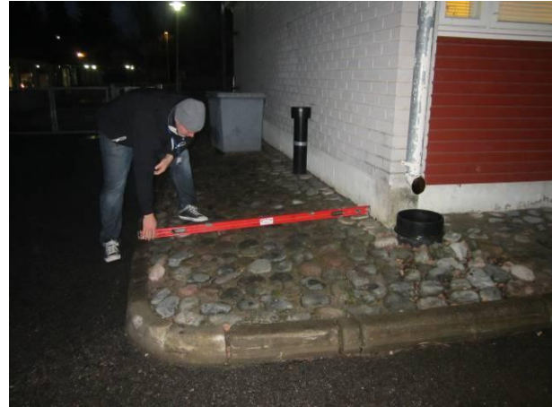
Kuva 2 Kallistukset ovat riittävät n. 1:20.
