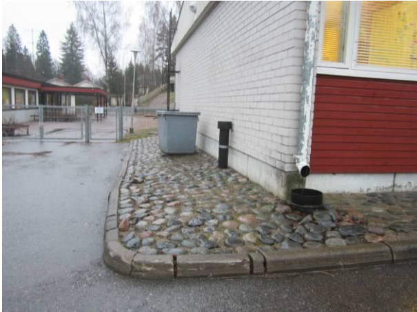
Kuva 1 Koillispääty, jossa on hiekkaan upotettu kenttäkiveys.
