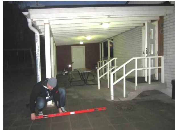
Kuva 8 Lounaispäädyn laatoitus on tasainen. Päädyssä on alustatilan tuuletusputkia.
