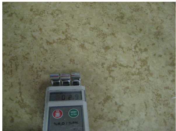
Kuva 18 Lattiain pintakosteusarvot olivat ulkoseinien vierellä ja muuallakin kuivaa rakennetta vastaavat.
