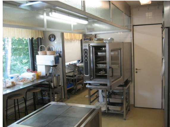
Kuva 22 Yleiskuva keittiöstä, jonka lattiassa on hartsipinnoite.
