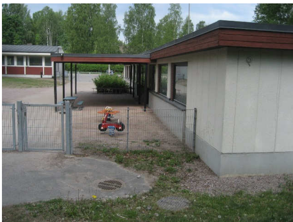
Kuva 5 Kaakkoispäädyn pintavesikaivo ja perusvesikaivo, taustalla katos.
