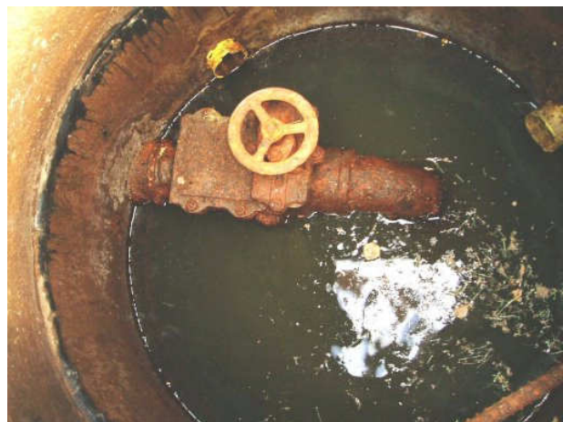
Kuva 8 Ruostunut padotusventtiili.
