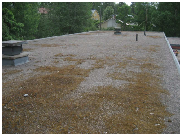
Kuva 12 Yleiskuva vesikatolta, jossa kallistuksia ei juuri ole.
