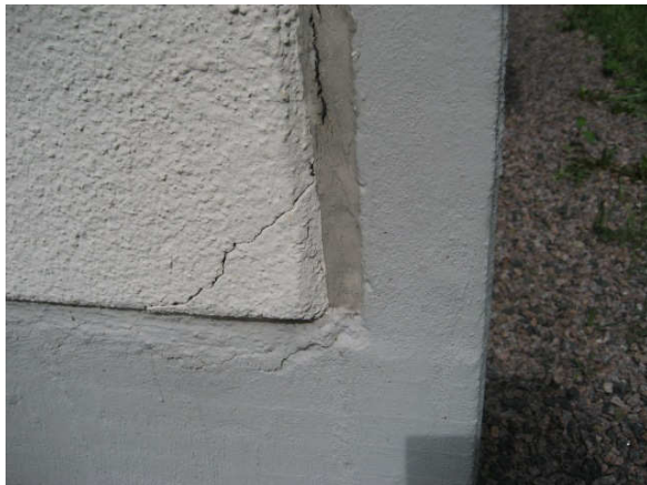
Kuva 9 Kaakkoispäädyn itäkulmalla on siporex-lohjenut ja saumausmassa on halki.
