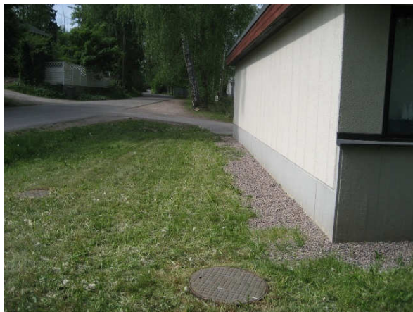
Kuva 3 Kaakkoispäädyn itäkulmalla on salaojien tarkastuskaivo. Maanpinnat ovat tasaiset tai viettävät kohti rakennusta. Päädän keskellä on kylmä kohta.
