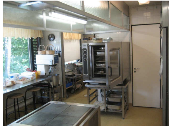
Kuva 22 Yleiskuva keittiöstä, jonka lattiassa on hartsipinnoite.
