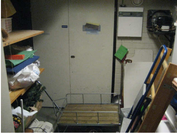
Kuva 25 Luoteispäädyn tarvikevarasto/ tekninen tila.
