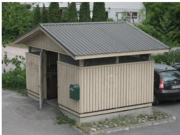
Kuva 6 Jätekatos palvelee kahta muutakin päiväkotirakennusta.
