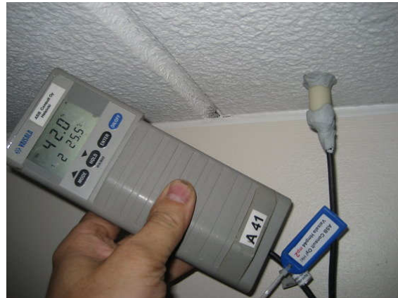
Kuva 2 PRK 7:n kosteusmittaus.
