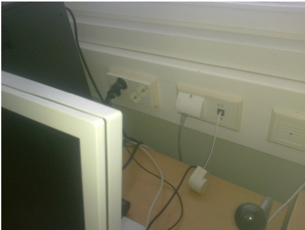
S- kuva 7. Kiinteistön puhelinjärjestelmä on uusittu pääosin yleiskaapelointijärjestelmäksi.
