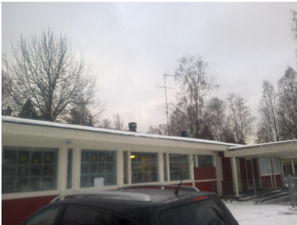
S-kuva 8. Kiinteistö on varustettu kiinteistökohtaisella antennijärjestelmällä.
