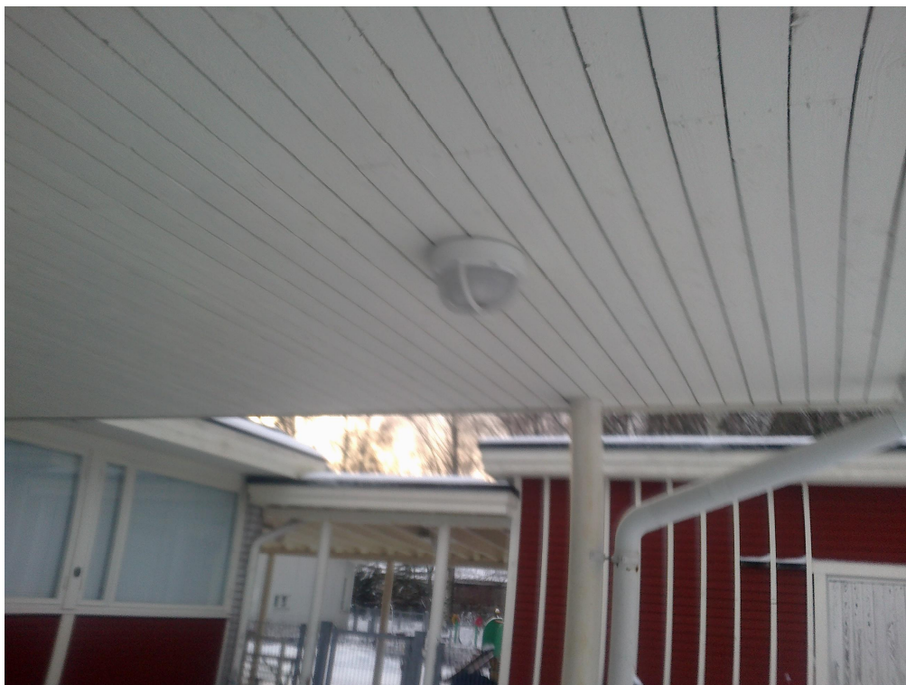
S- kuva 5. Valaisimien uusimisen aiheuttaa lähinnä EUP- asetus, joka poistaa osan valonlähteistä sekä liitäntälaitteista markkinoilta vuosina 2010- 2017 (esim. elohopealamput v. 2015).
