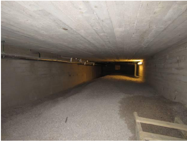
Kuva 13 Pihasisvun ontelotilaa tilojen 06, 11, 13 ja 21 alla. Kunto on hyvä.
