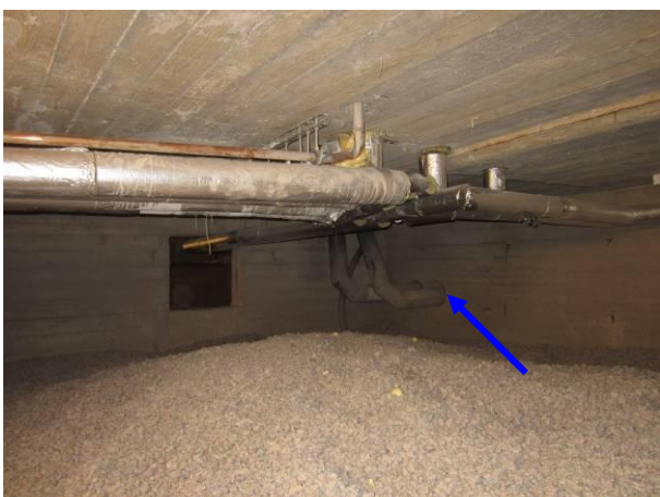
Kuva 21 Putkiläpivientejä katon läpi ja perusmuurin läpi. Kulkuaukko 01 ja 02 alle.
