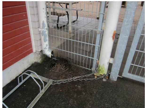
Kuva 8 Rännikaivo tilan 02 kulmalla.
