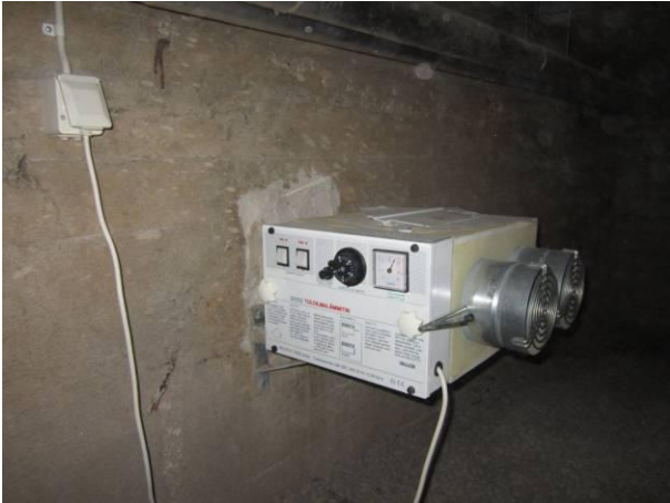
Kuva 3 Tuloilmapuhallin, jossa on lämpövastus.
