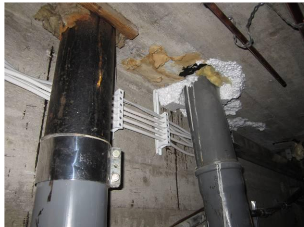
Kuva 16 Putkikanaalin läpivientejä.
