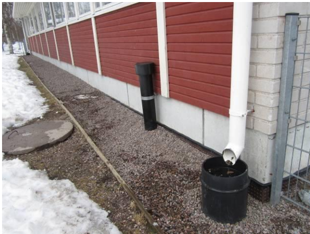
Kuva 1 Salaojan tarkastuskaivon betonikansi, muovinen tuuletusputki ja rännikaivo. Perusmuuria vasten on sokkelilevy.
