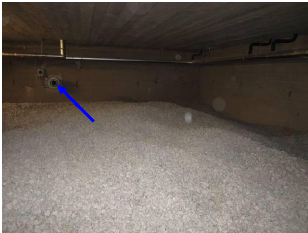
Kuva 19 Ontelotilaa tilojen 01 ja 02 (25) alla, peräseinällä on poistopuhallin
