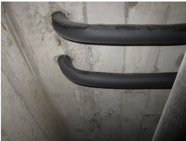
Kuva 15 Lämmitysputkien läpivienti.
