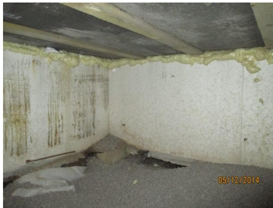
16. levyjen alapinnassa hieman kupruilua ja väriä
