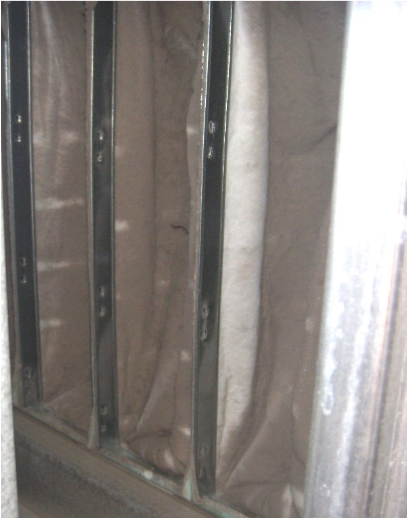
KUVA 7. Yleiskuva poistoilmasuodattimesta.
