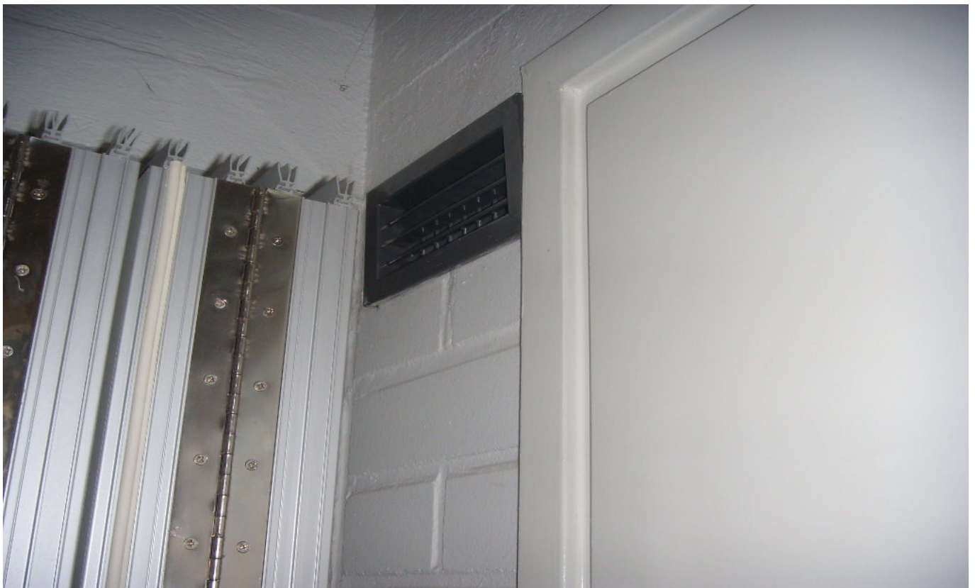
KUVA 26. Heittokuvioiden edessä on väliseinäelementtejä.
