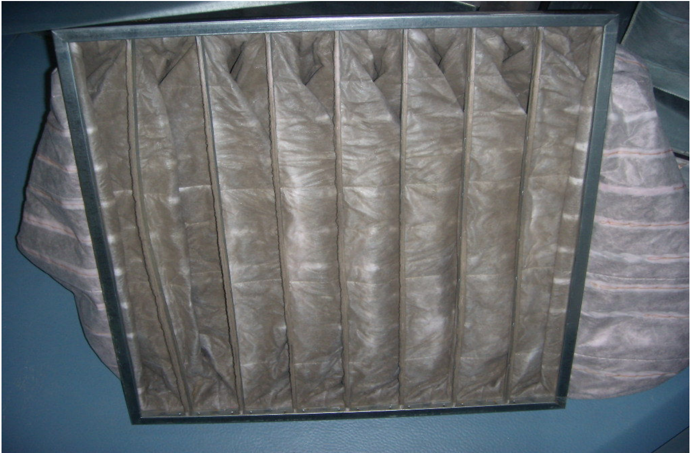
KUVA 15. Yleiskuva tuloilmasuodattimesta.
