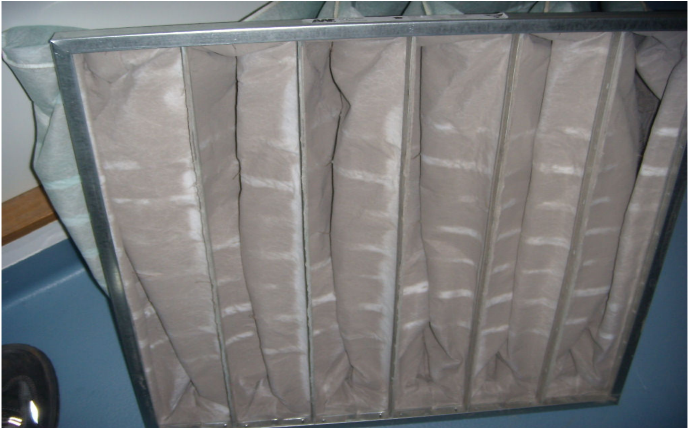
KUVA 17. Yleiskuva poistoilmasuodattimista.
