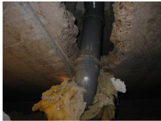
Kuva 18 Tyypillinen viemärin läpivienti onteloiden läpi.
