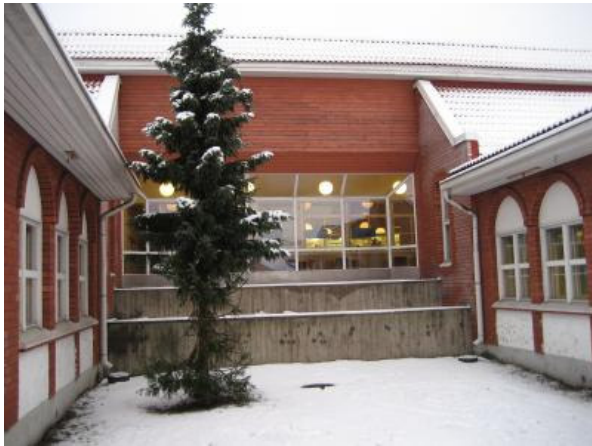
Kuva 23 B- osan ja C-osan välinen piha. Ryömintätiloihin on tuuletusventtiilit sokkelissa, mutta alustaan ei ole pääsyä.
