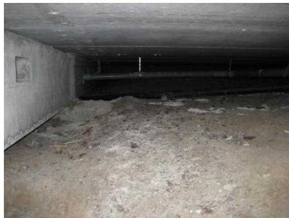
Kuva 2 Yleisnäkymä pohjoislohkoon, jossa maanpinnassa on paikoin kasvustoa.
