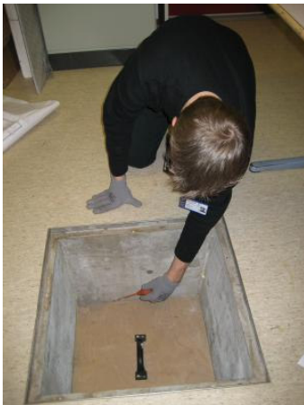
Kuva 1 Luukkujen raoista tulee korvausilmaa.
