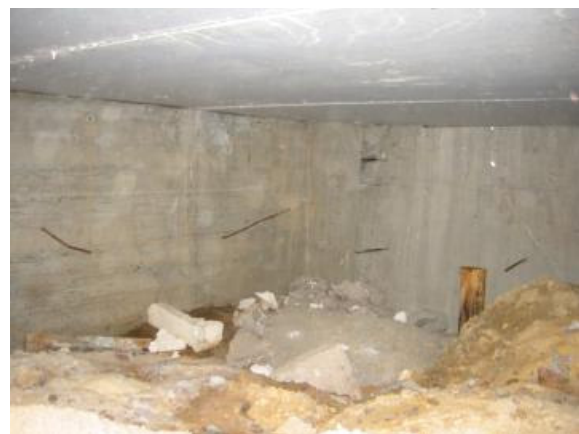
Kuva 28 Luoteiskulmalla ryömintätila on muuta aluetta syvempi.
