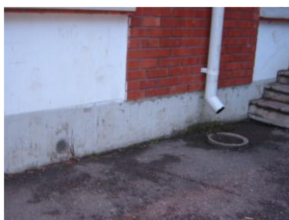
Kuva 22 Itäsivulla oleva tuuletusputken pää, jossa edessä on venttiili. Aukko on lähellä maanpintaa
