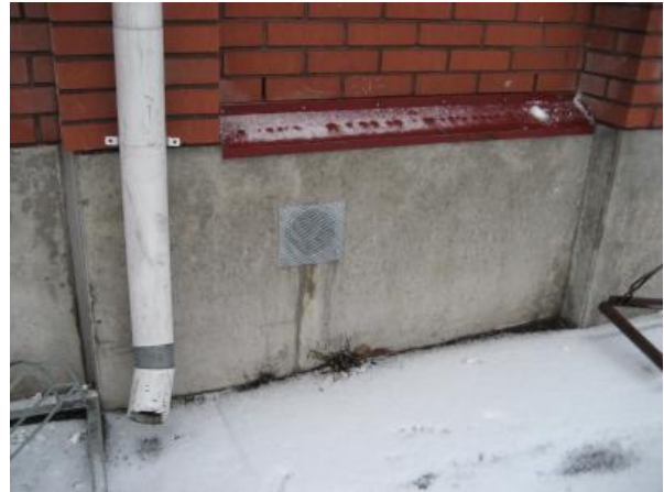
Kuva 14 Eteläsivulla sekä itä- ja länsipäädyssä päädyssä tuuletusaukkojen edessä on ritilät.
