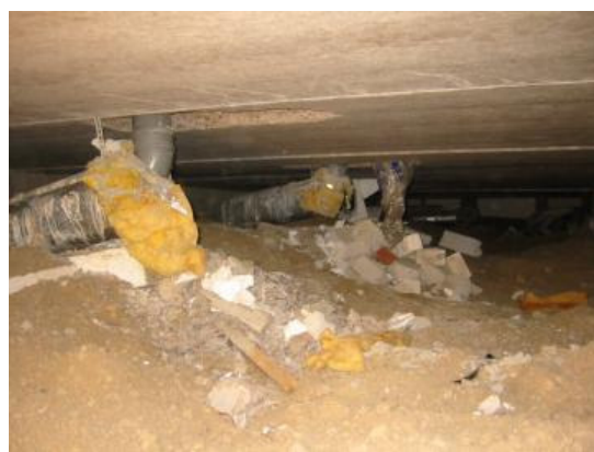
Kuva 16 Käytävän kohdalla kulkee pohjaviemärisoran ja polystyreenin alla. Haarotusten eristeet repsottavat. Tilassa on roinaa.
