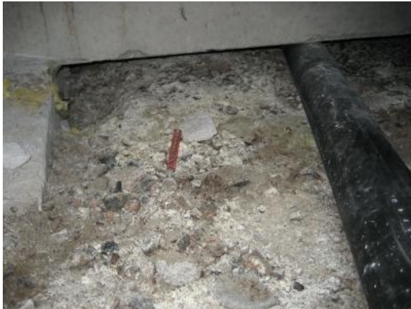
Kuva 7 Maanpinnassa olevaa kasvustoa pohjoislohkon ja keskiloikon rajalla
