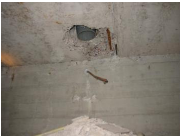
Kuva 21 Itäsivulla oleva tuuletusputken pää.
