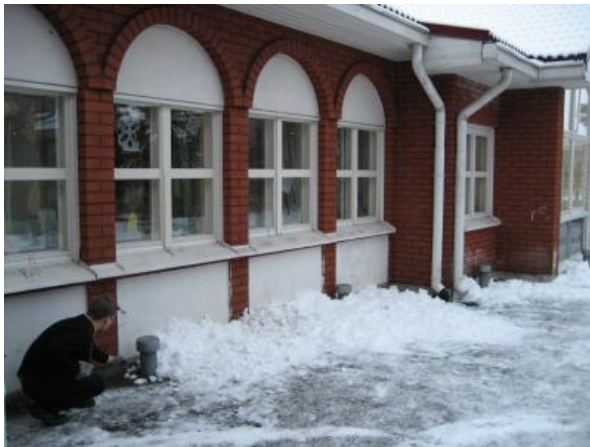
Kuva 13 Pohjoissivun ulkoseinien vieressä on tuuletusputket ryömintätilaan, ilma virtasi ryömintätilan suuntaan.
