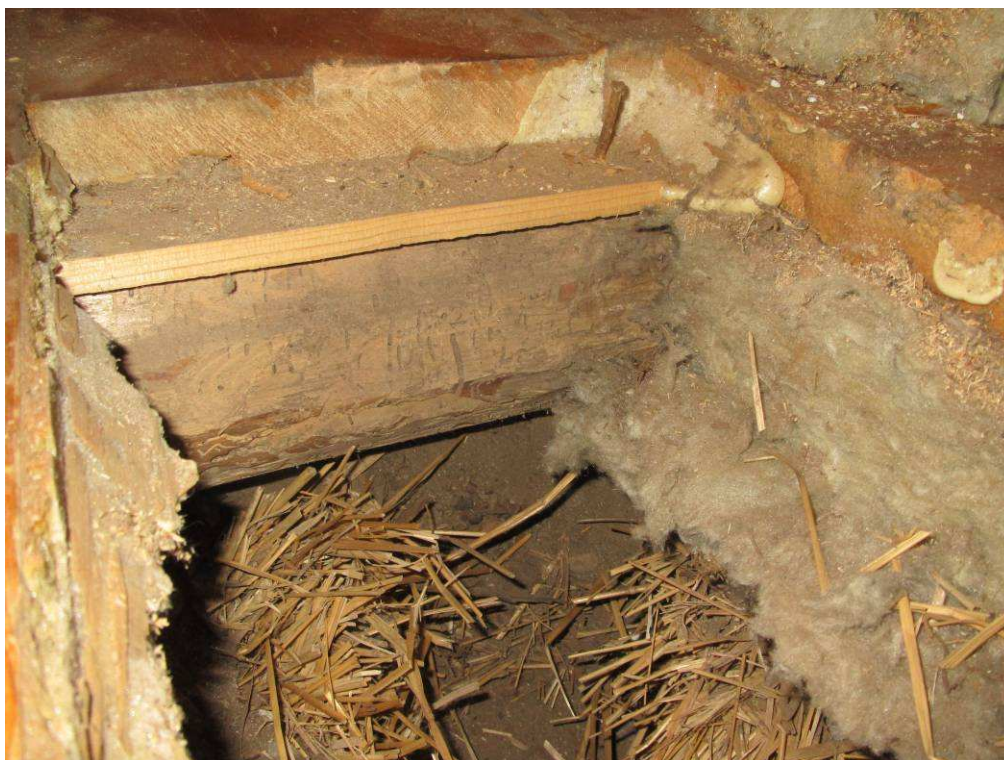
Kuva 8. Rakenneavaus 3, alapohjaeristeenä alimpana olkea ja hiekkaa
