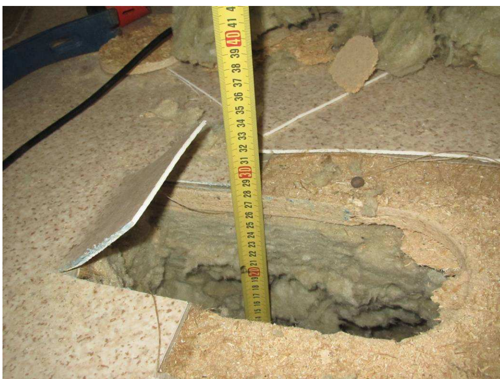
Kuva 9. Rakenneavaus 4, eristeenä 250mm mineraalivillaa
