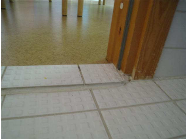
Kuva 43 Märkätilan kynnyksen on liian matala.
