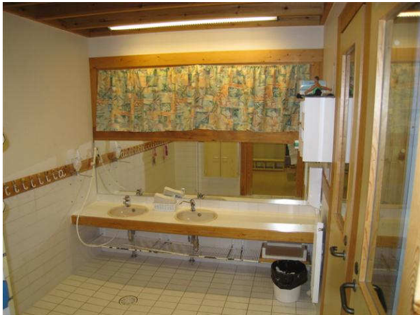
Kuva 37 Yleiskuva lasten wc-pesutilasta.
