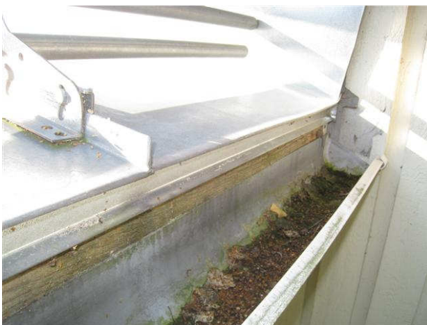
Kuva 23 Räystäiden otsalaudat kastuvat ja vesi valuu osin rännin ja otsalaudan välistä. Ränneissä puhdistustarvetta.
