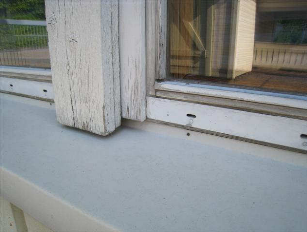
Kuva 25 Ikkunoiden alaosien maalipinnat ja pielilaudat ovat kuluneet.
