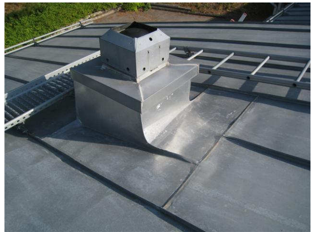
Kuva 34 IV-puhaltimien piippujen läpiviennit on tehty hyvin, kate on hyväkuntoinen.
