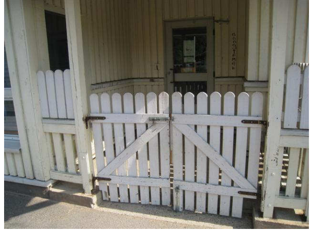
Kuva 20 Lounaispäädyn portti ja korotetut kaiteet muodostavat näkösuojan.
