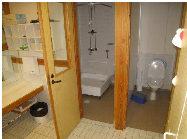
Kuva 38 Lasten wc-pesutilan suihkutila+wc ja erillinen wc-tila.
