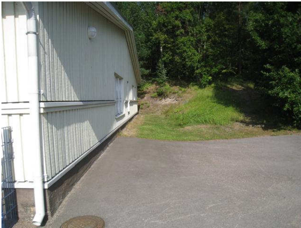
Kuva 15 Koillispääty, maasto viettää kohti rakennusta luoteiskulmalla.
