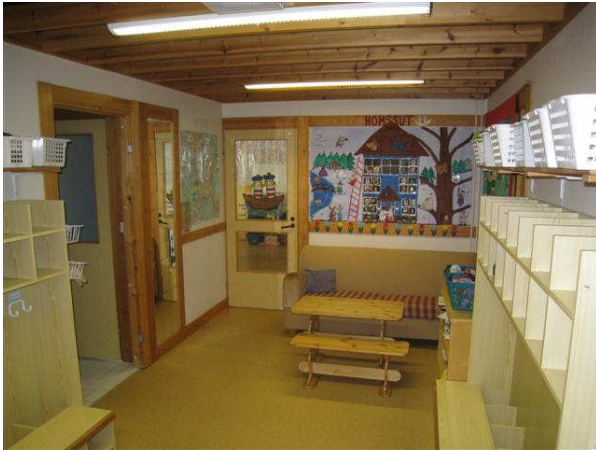
Kuva 49 Yleiskuva eteistilaan, jossa on alakattona puupalkisto, pölyttyä helposti.
