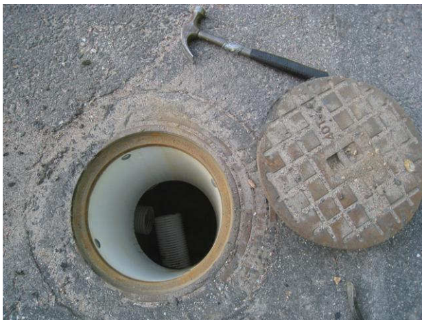
Kuva 9 Tarkastettu salaojakaivo lounaiskulmalla.
