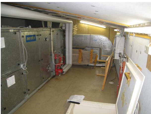
Kuva 47 Yleiskuva ullakon IV-konehuoneesta, jossa on puurakenteisen välipohjan lattian vedeneristeenä muovimatto.
