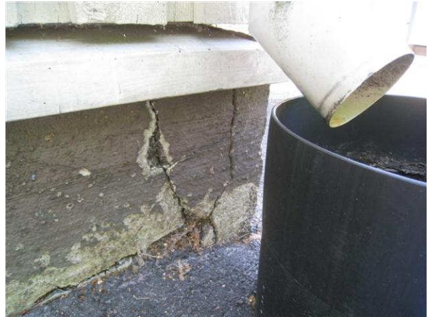
Kuva 14 Sokkelin halkeilua.
