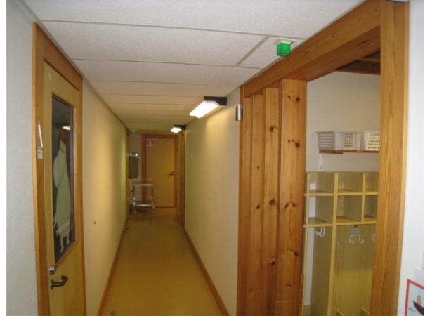
Kuva 50 Yleiskuva käytävälle, jossa on alakattona levyt.
