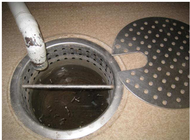
Kuva 36 Märkäeteisen lattiakaivossa on siivilä.
