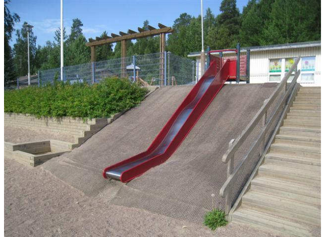
Kuva 2 Liukumäen alaosalla on maa painunut, verkkoja pidetään epäkäyttännöllisinä.
