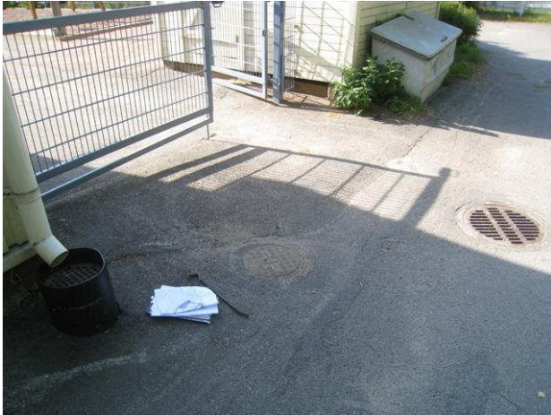
Kuva 7 Lounaiskulman tarkastettu rännikaivo, kesk. salaojakaivo ja sadevesikaivo.
