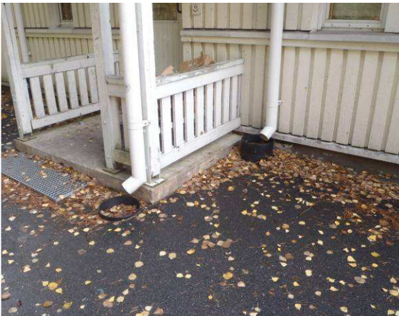
Rännikaivot syökyjen alla. Osin sokkelin korkeus maanpintaan nähden on melko matala.
