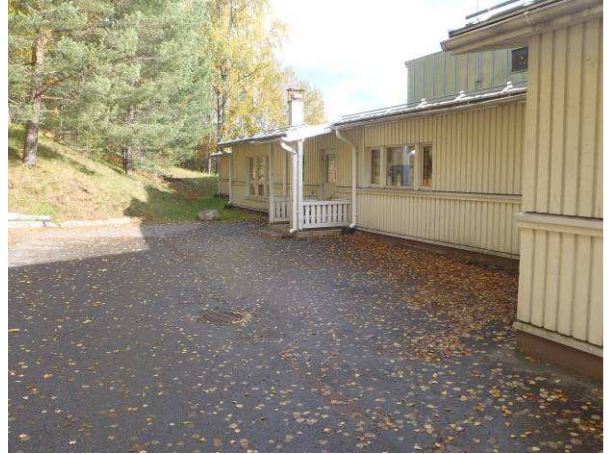
Kuvaa länsipuolelta, pintavedet ohjautuvat kallistuksen keskellä olevaan sadevesikaivoon.
