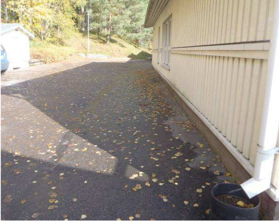
Kuvaa länsisivustalta, jossa kallistus eteläpäädyssä lähtien on riittävä.
