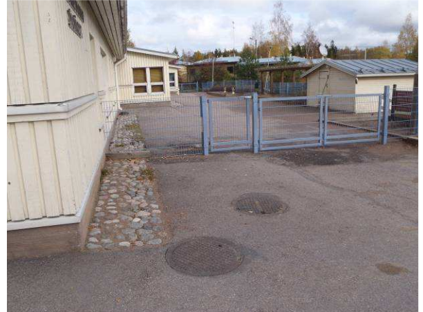
Itäisivulla kallistukset ovat riittävät, myös sokkelin korkeus maanpintaan nähden on riittävä.
