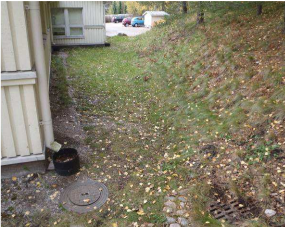
Länsisivun sadevesikaivo on aivan talon päädyssä.
