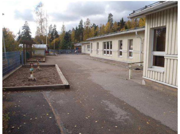
Maanpinta kallistuu pois rakennuksesta. Piha on asfaltoitu, sadevedet ohjautuvat sadevesikaivoihin.
