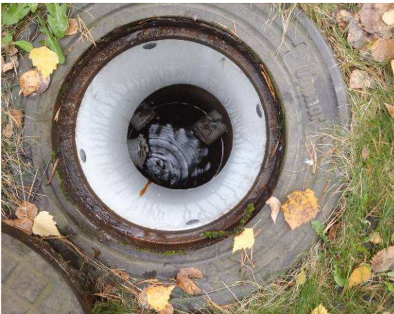
Salaojakaivon länsisivun keskiosalla.
