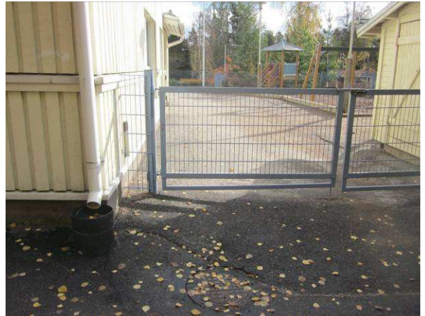
Pinnat eteläosalla rakennuksen vierustalla on asfalttia.
