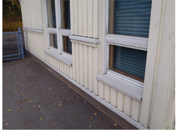
Vesipeltien kallistukset ovat loivia.
