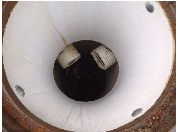
Salaojakaivossa ei havaittu vettä. Salaojat ovat oletettavasti perustusten alapinnan tasolla.
