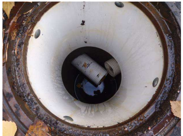
Salaojakaivo. Putket ovat lähellä perustamistasoa.
