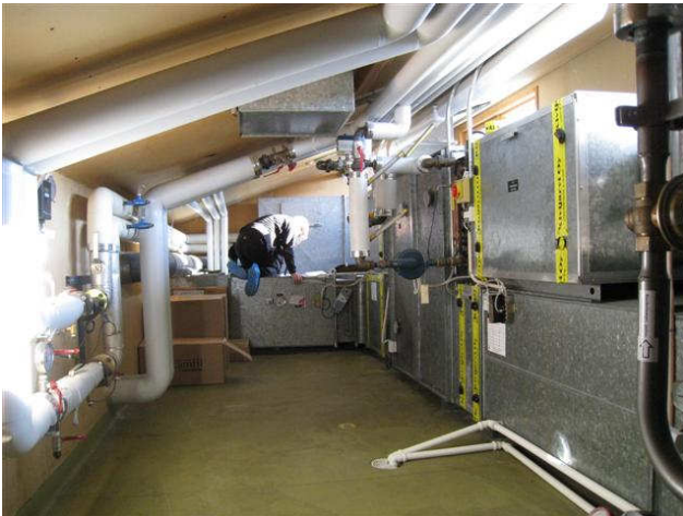
Kuva 35 Yleiskuva ullakon IV-konehuoneeseen, jonka lattiakaadot ovat vähäiset.
