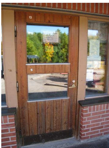
Kuva 9 Puisten ulko-ovien toimivuus on huono ja pinnat ovat kuluneet.
