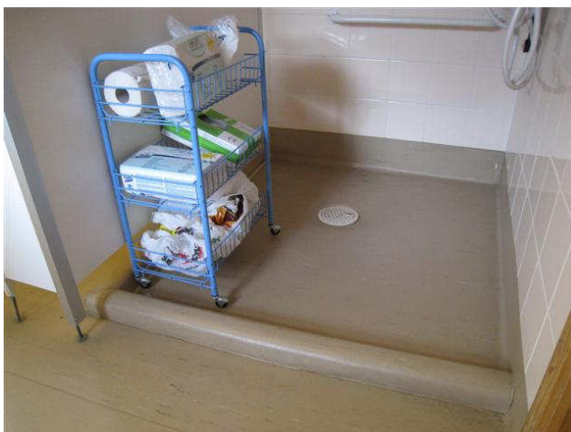
Kuva 33 Suihkunurkka, johon on tehty allas
