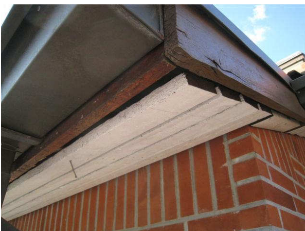
Kuva 15 Tältä kohdista tarkistettiin vesikaton rakennetta vaatehuolto 23 kohdalta.
