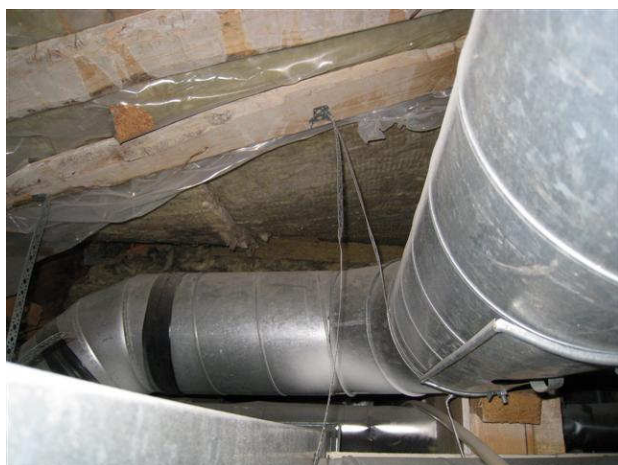
Kuva 21 Tässä kohdin puuttuu höyrystulun isolta alalta kokonaan.
