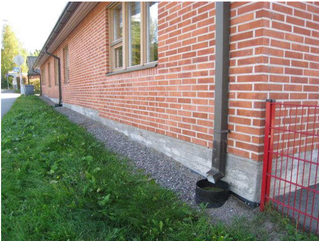
Kuva 1 Pintakallistukset ovat pääosin riittävät, nurmialueilla sokkelin vierellä on sepeli. Kattosadevedet on johdettu viemäriin.
