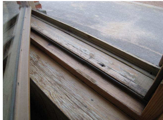
Kuva 8 Vesijälkiä tuuletusikunoissa.
