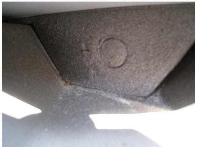
Kuva 14 Harjapeltien alla on tuulisuojarahjoit, mutta tuuletus on puutteellinen, koska tulpat ovat monin paikoin paikoillaan.
