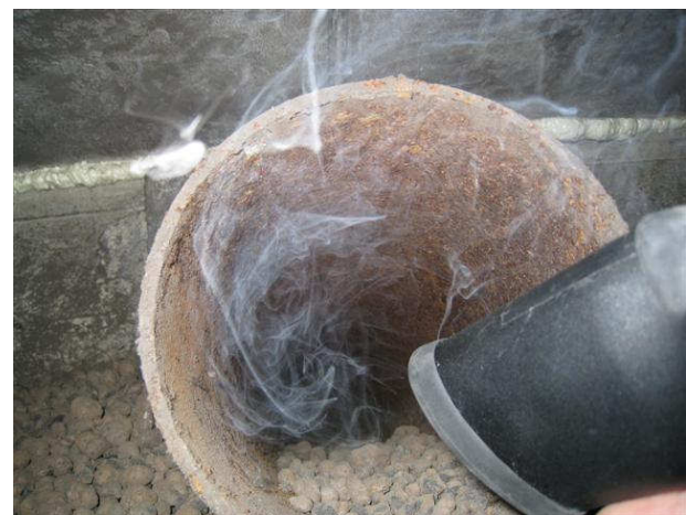
Kuva 8 Korvausilmaputkissa ilma liikkui savukokeen mukaan välillä sisään- tai ulospäin. Koe tehtiin eteistilan 42 alla.
