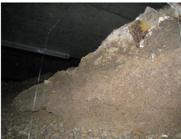
Kuva 13 Vaaleaa kasvustoa märässä maassa peruspalkin kaivannon kohdalla tilan 49 alla. Ilma on kostea ja haisee mikrobeille. Yläosalla vaaleaa kasvustoa.
