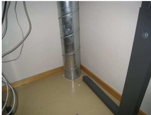
Kuva 5 Alustatilan v. 2003 tienoilla lisätty tulo- tai poistoilmakanava varastossa 37.
