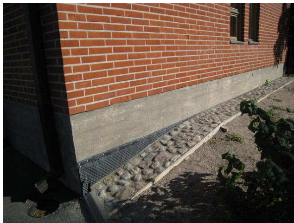
Kuva 17 Sokkelia vasten on asennettu sokkeli-levy leikki- ja lepo huone 44 kulmalla.
