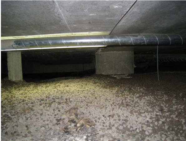
Kuva 9 Yleiskuva alustatilaan käytävän 48 ja liikuntasalin 38 alla.
