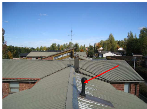
Kuva 18 Vesikatolla on alustatilan poistopuhaltimia. Puhaltimille ei ole kattosiltaa.
