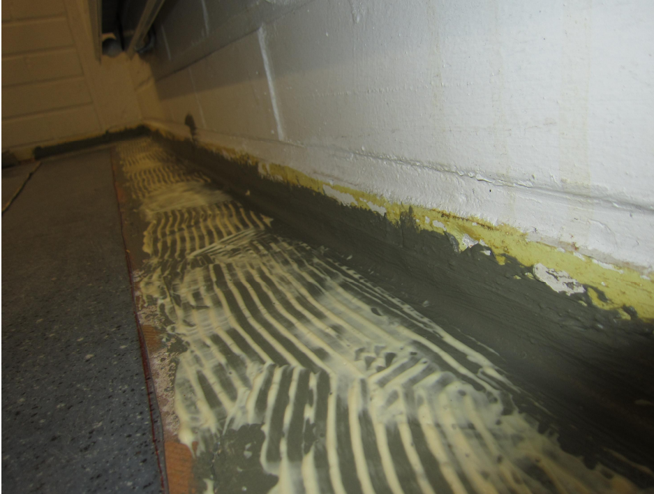
Kuva 2. Kuva on lattia-seinäliittymän tiivistyksestä.
