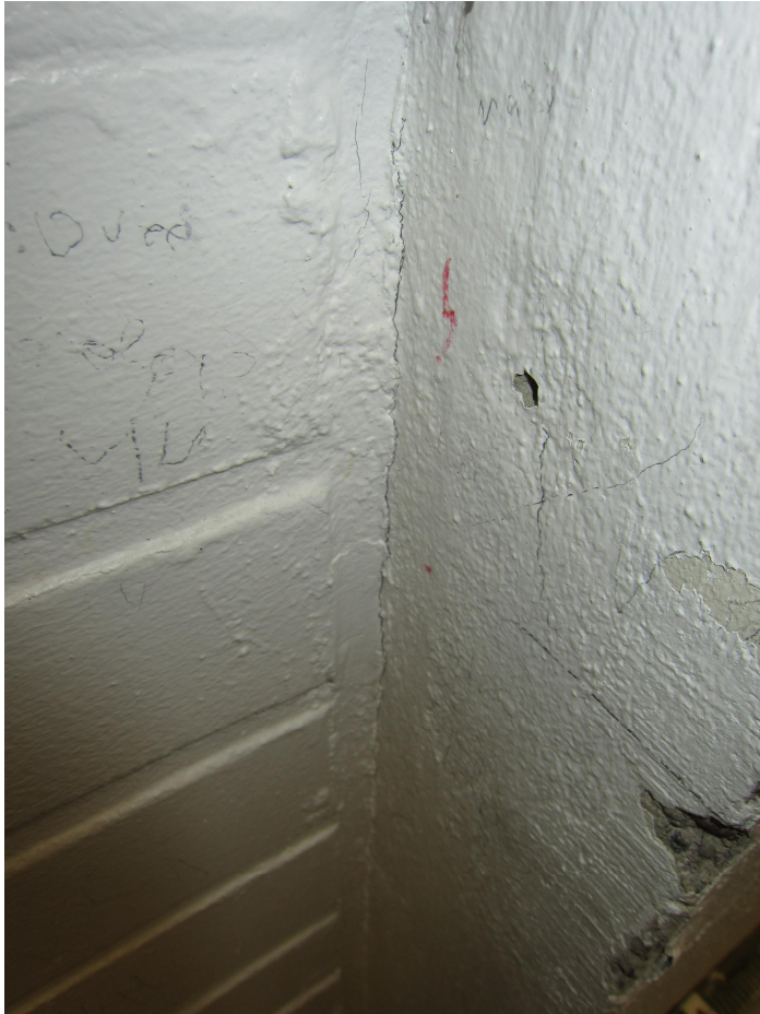
Kuva 1. Kuvassa näkyy tiilimuuratun sisäkuoren liittyminen pilariin.
