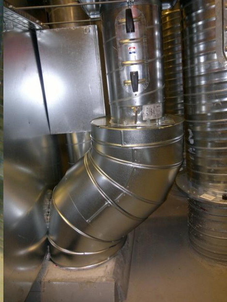
Eriste asennettu ja pellitetty.
