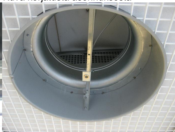
Kuva korjatusta asennuksesta
