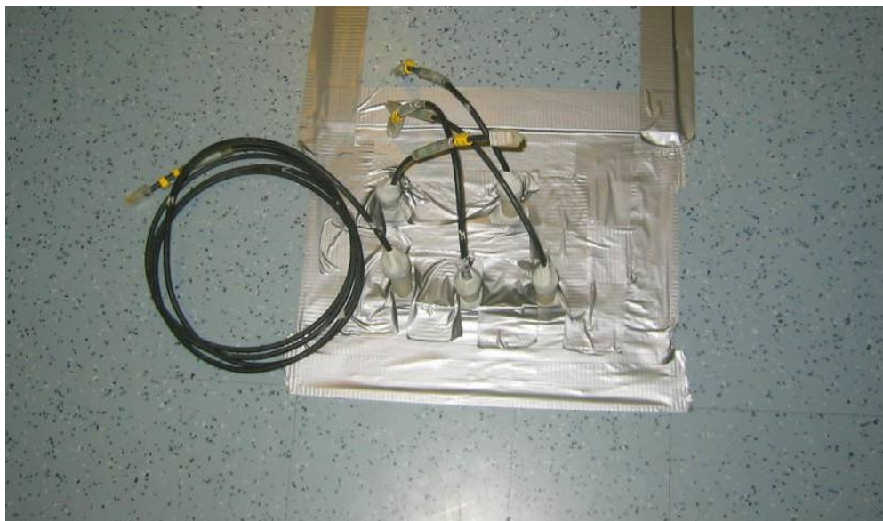
Kuva 1. Yläkuvassa viiltomittauksia muovimaton alta ja alakuvassa mittapäät tiivistettyinä vinylilaatan alle tehtyyn porareikämittauskohtaan.
