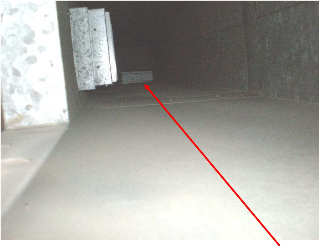
KUVA 13. Kerhuhuoneen no:119 tuloilmakanavassa on irronnut säätöosa.
