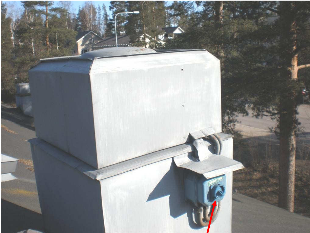
KUVA 8. PF3. Huippuimurin turvakytin on rikki.
