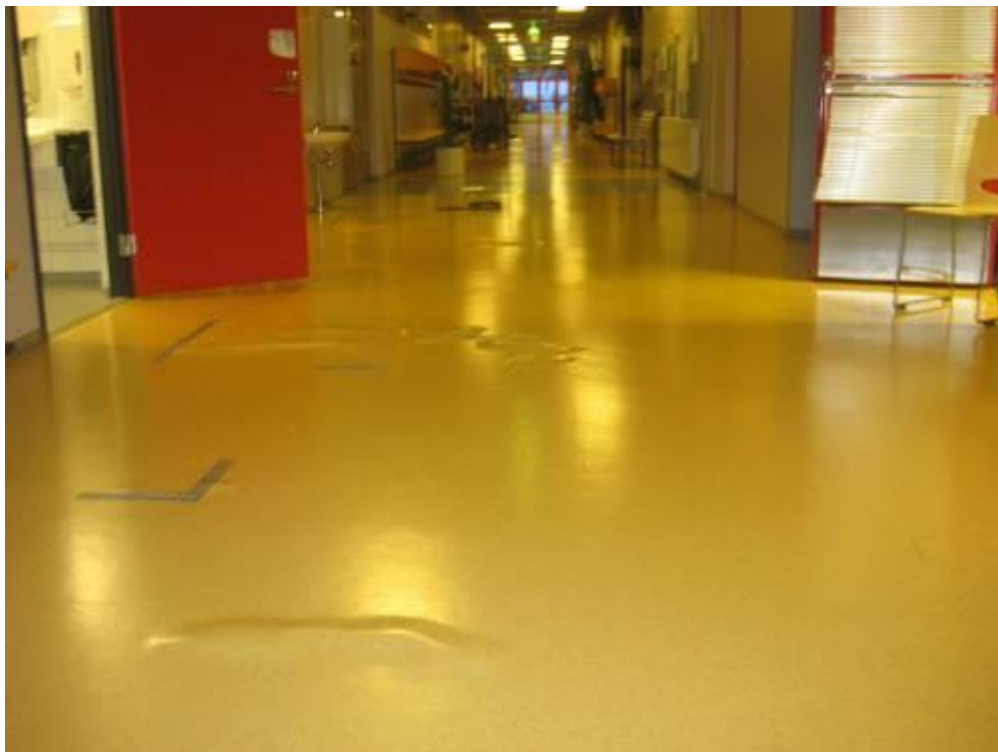
Kuva 4. Hiekkaharjun koulun pääkäytävän peruskorjauksen jälkeen jo kertaalleen uusitun kumimaton kupruja.
