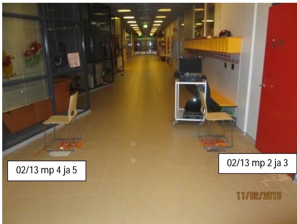
Kuva 7. Hiekkaharjun koulu, käytävän 1100 alapohjarakenteen suhteellisten kosteuksien mittaukset käynnissä mittapisteissä 02/13 mp 2, mp 3, mp 4 ja mp 5.
