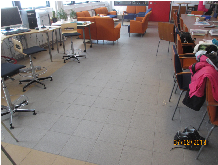
Kuva 3. Hiekkaharjun koulu, kiviaineisella laattalla laatoitettujen tilojen lattiapäällysteet ovat siistikuntoiset.
