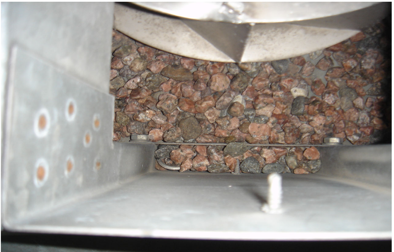
KUVA 20. Yleiskuva vesikatolla olevasta huippumurista.
