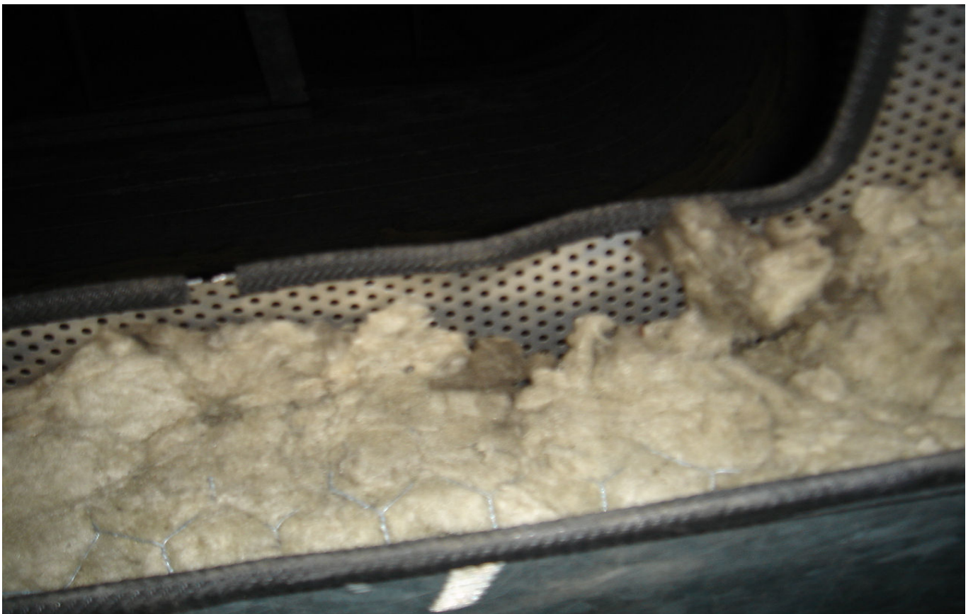
KUVA 24. Yleiskuva tuloilmakanavan eristyksestä.
