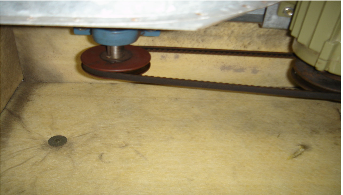
KUVA 17. Tuloilmakoneen kammiot on eristetty mineraalivillalla.
