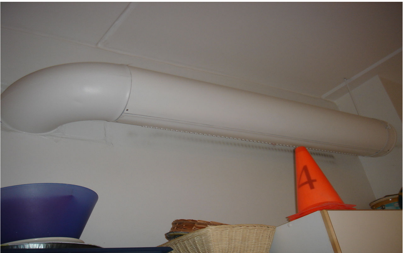
KUVA 26. Yleiskuva uuden puolen luokkahuoneiden ns. reikäputkesta.
