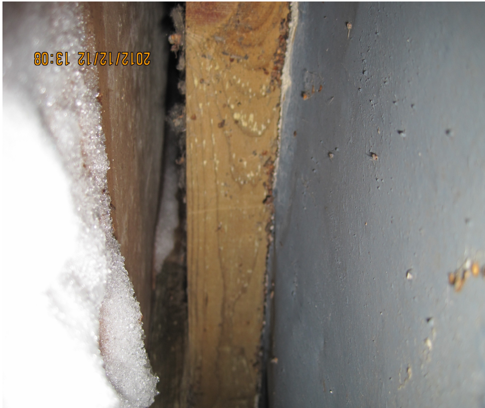
Kuva julkisivulevyn takaa tuuletusraosta
