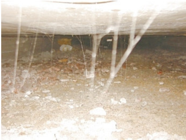
Kuva 5 Rossitilassa ei havaittu vaurioita eikä poikkeavaa mikrobikasvustoa.
