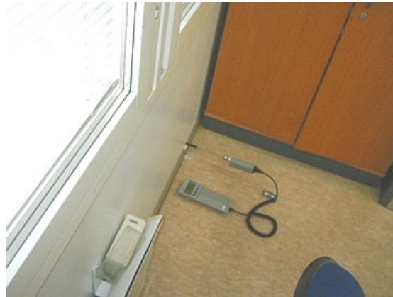
Kuva 2 Rakenteissa ei poikkeavaa kosteutta havaittu.
