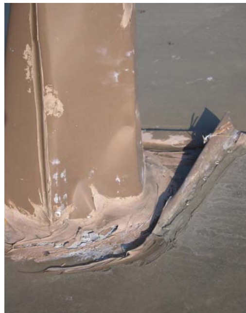
Kuva 20. Antennin tyvikartiopellin ja katepellin liitosauman tiivistemassat ovat irtoilleet.
