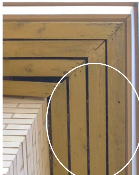
Kuva 24. Linnunpesä räystäslautojen päällä (ympyrä). Pääsy räystäsrakenteisiin ja yläpohjan onteloon irronneen laudan takia.
