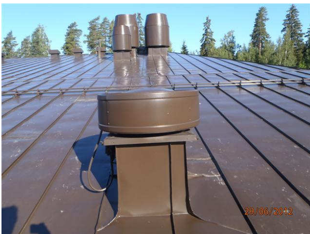
kuva 5 Kotitalousluokkia palveleva poistoilmakone 1PK3.
