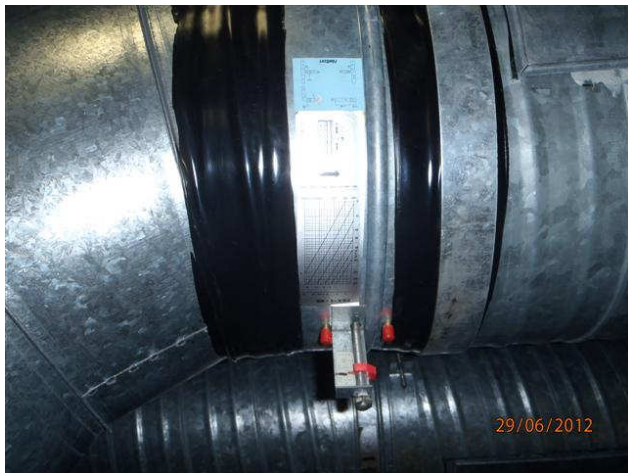
kuva 3 Käsisäätöinen säätöpelti mallia PRA. kuva 4 Moottoriohjattu vyöhykepelti.
