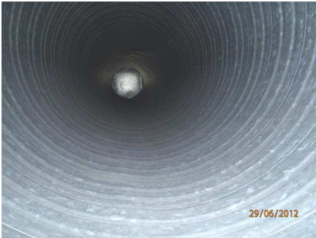
kuva 1 Poistoilmakoneen 1PK1 puhdas kanava kuvattuna iv-konehuoneessa 301. kuva 2 Huippuimurin 1PK3 kammio ja kanavaa vesikatolta kuvattuna.
