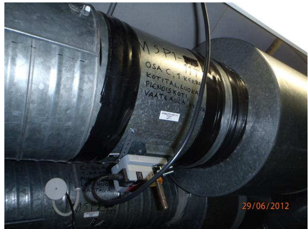
kuva 3 Käsisäätöinen säätöpelti mallia PRA. kuva 4 Moottoriohjattu vyöhykepelti.
