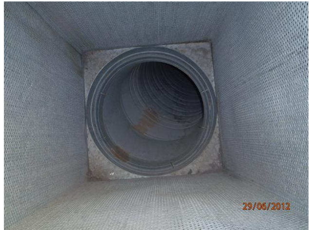
kuva 1 Poistoilmakoneen 1PK1 puhdas kanava kuvattuna iv-konehuoneessa 301. kuva 2 Huippuimurin 1PK3 kammio ja kanavaa vesikatolta kuvattuna.
