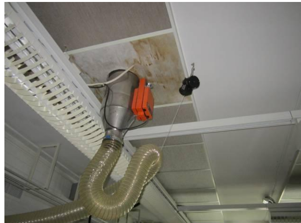
Kuva 26. Vuotojälkiä Fysiikka 258.
