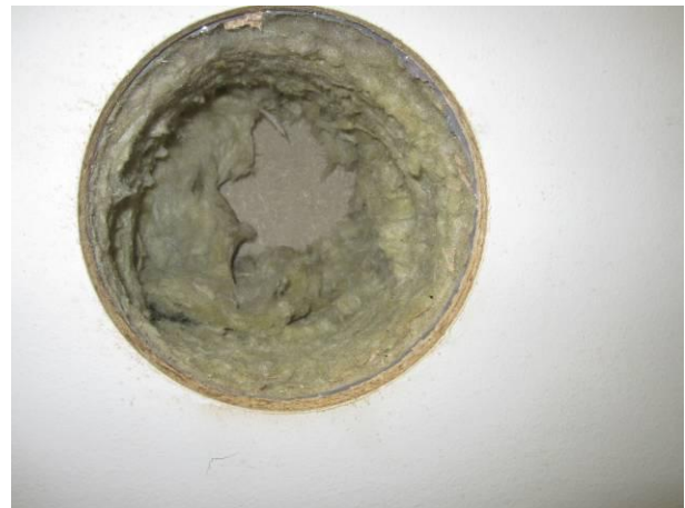
Kuva 32. Rakenneavaus ulkoseinän levytyk- sen kohdalle, vikoja ei havaittu.
