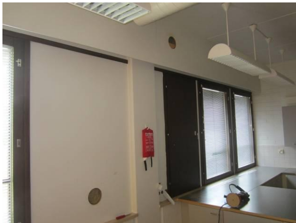
Kuva 31. Rakenneavausseinä kotitalousluokassa 070, josta on otettu ilmanäytteitä seinän sisältä.
