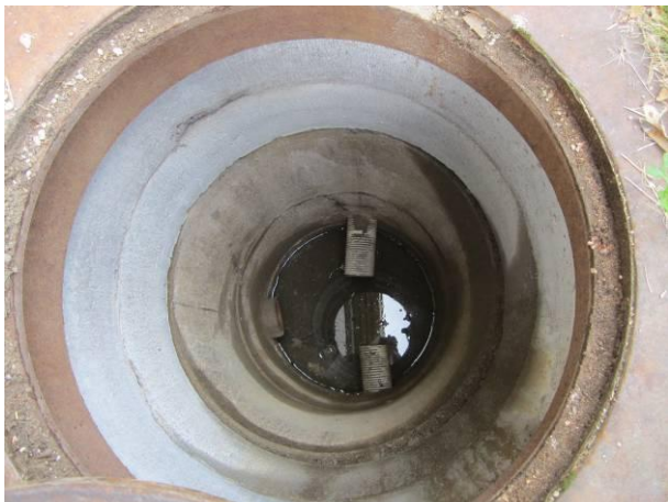
Kuva 21. Korjattu salaojakaivo kotitalousluokka 071 kohdalla, tiilisalaoja tulee talon alta.
