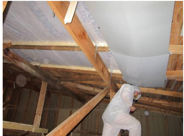
Kuva 12. Vuotokorjauksina aluskatetta ja peltikouru tilojen 263 ja 264 tienoilla.
