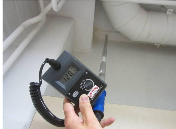
Kuva 30. Vuotojälkiä pimiö 120 katossa, jos- sa pintakosteus oli selvästi koholla.
