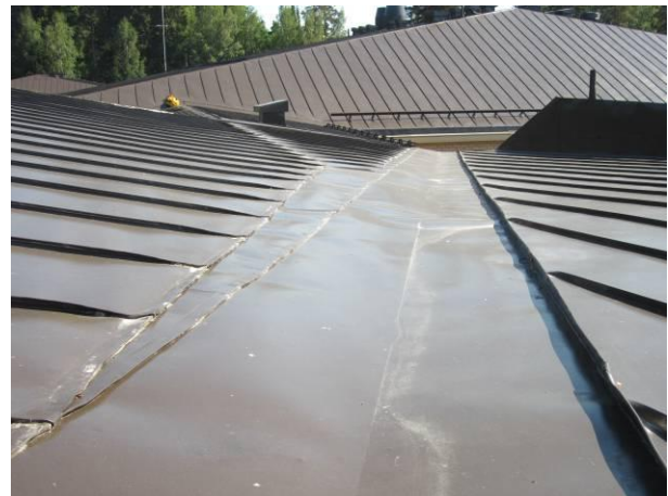
Kuva 2. Loiva jiriteite, jossa on tehty tiivistyskittauksia liikuntasali 017 sivulla.
