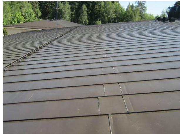
Kuva 6. Lappeella lähemmäs olevia jatkosauvoja, keskialueen lumieste.
