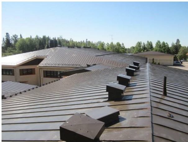
Kuva 1. Yleiskuva vesikatoilta, läpivientinä tuuletuspiiput, kattoluukku ja viemärin tuuletusputki.
