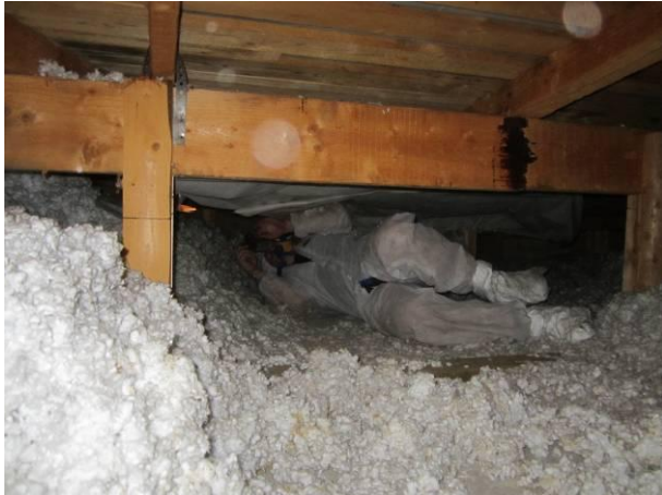
Kuva 15. Vuotojälkiä löytyi jiirin kohdalta tilojen 117 ja 120 kohdalta, eristettä puuttuu laajalti, koska on raivattu työskentelytilaa.
