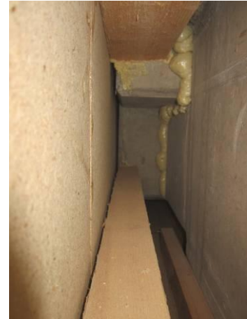
Kuva 34 Verhokotelossa ei havaittu vuotojälkiä eikä kosteusvaurioita.
