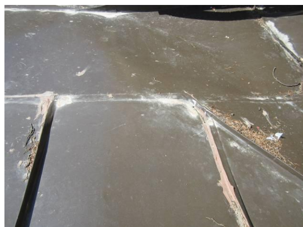
Kuva 8. Jiiritaitteen tiivistyskittauksia pimiö 120 yläpuolella.
