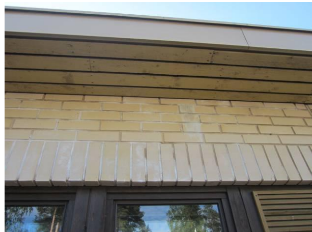
Kuva 18. Vuotojälkiä tilan 227 kohdalla
