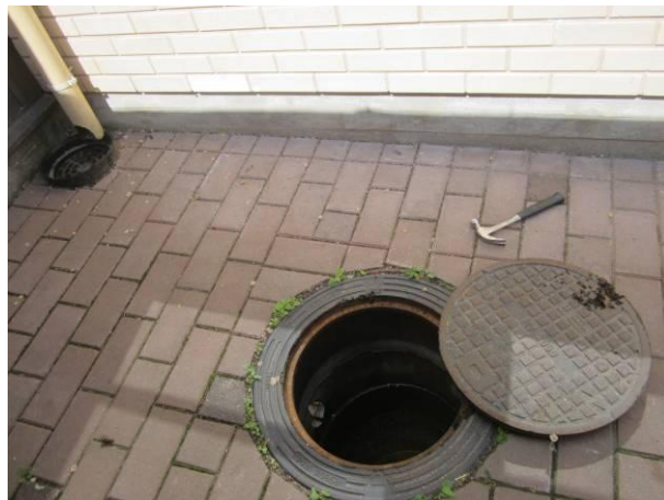
Kuva 22. Salaoja on matalalla kuvaamataito 117 nurkalla.
