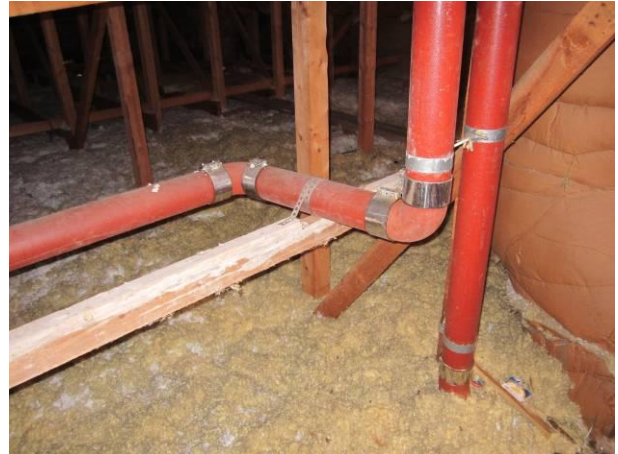
Kuva 16. Kaikki yläpohjan tuuletusviemärit ovat eristämättä.
