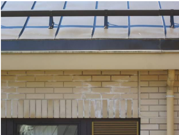
Kuva 17. Vuotojälkiä tilan 246 kohdalla.
