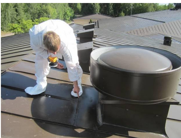
Kuva 7. Salin 017 poistopuhallin sijaitsee salin katon vuotolinjalla harjan vieressä.
