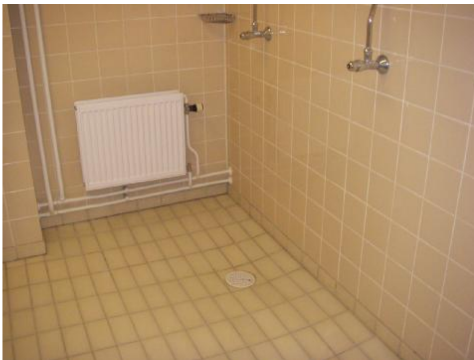
Suihkutilojen rakenteissa ei havaittu haitallista kosteutta.
