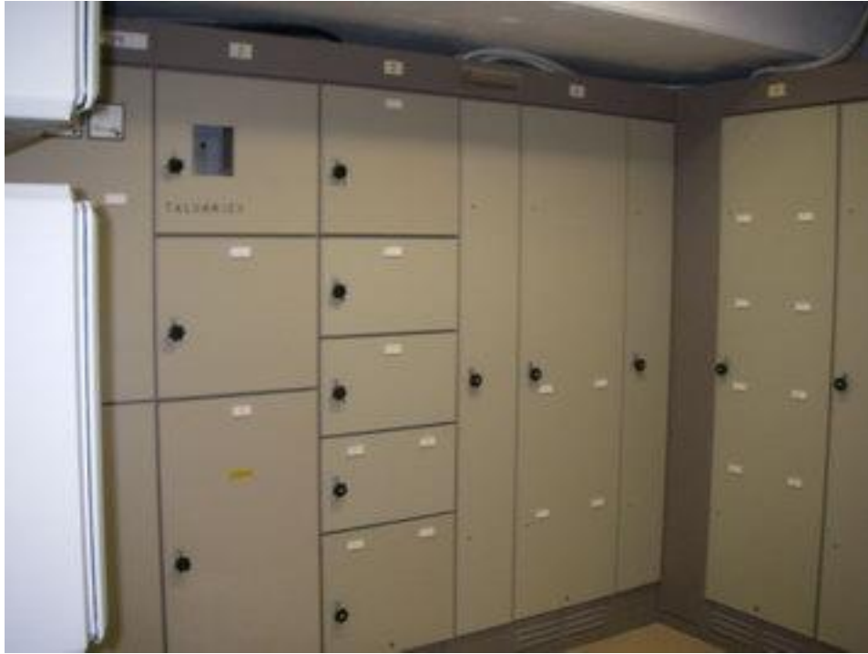
Kiinteistön sähköpääkeskus.
