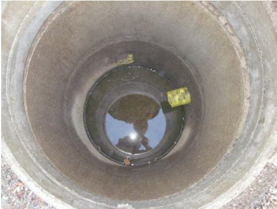
Salaojan tarkastuskaivo. Viitteitä salaojien puutteellisesta toiminnasta ei havaittu.
