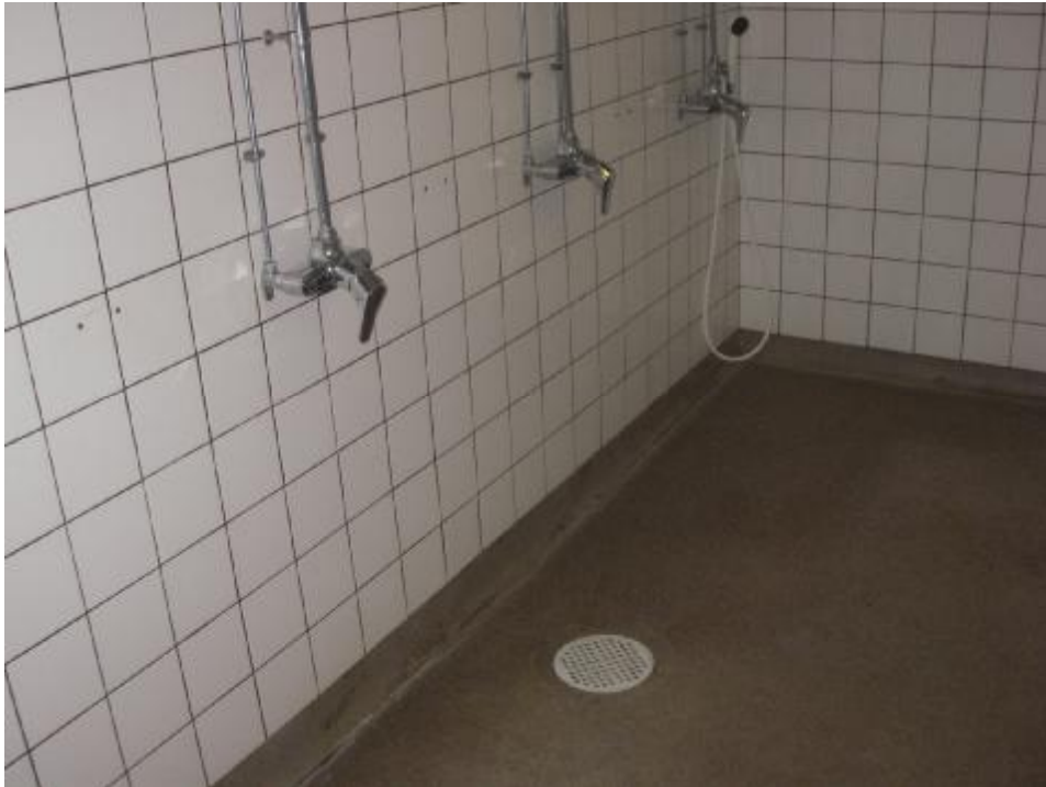
Liikuntasalin yhteydessä oleva poikien pesuhuone. Suihkutilojen rakenteissa ei havaittu haitallista kosteutta.
