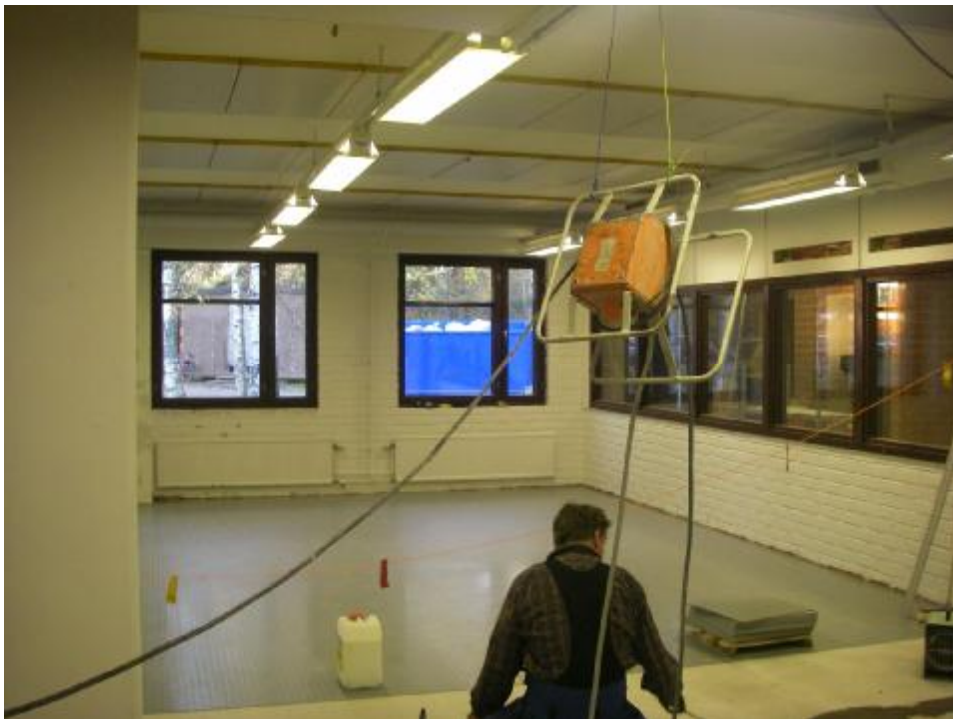
Puutyöluokan remontti on käynnissä.
