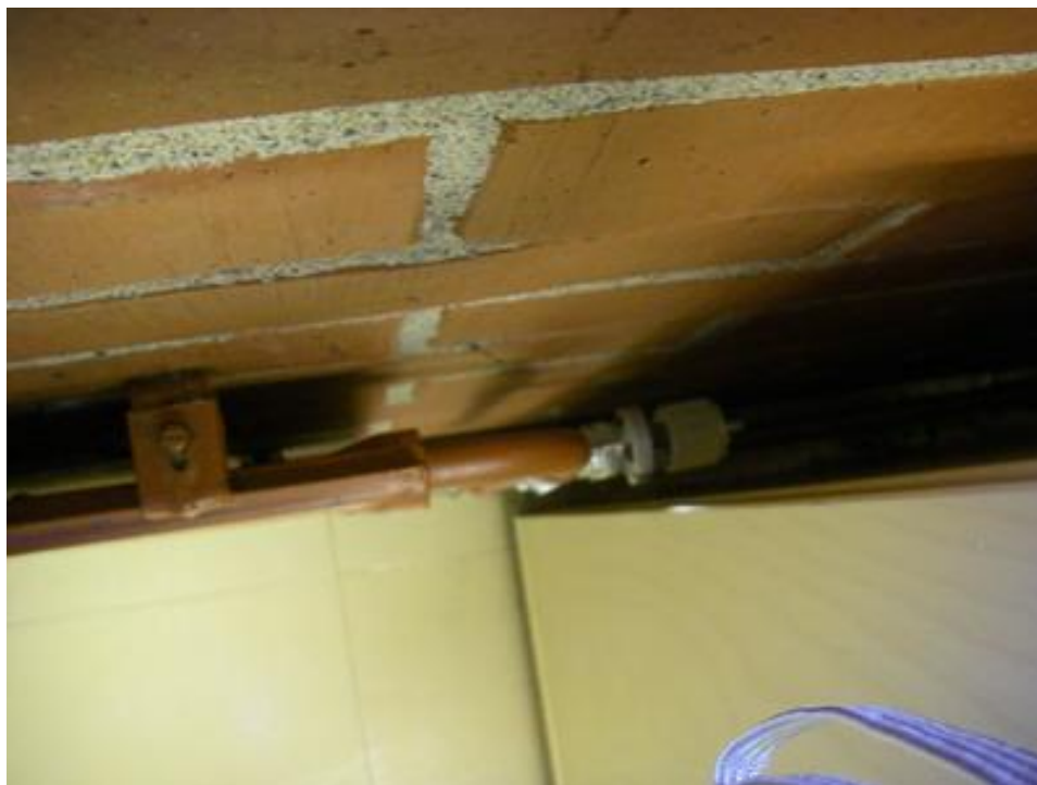
Termostaattiset patteriventtiilit uusitaan PTS-jakson puolivälissä.
