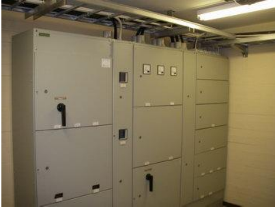
Kiinteistön sähköpääkeskus.
