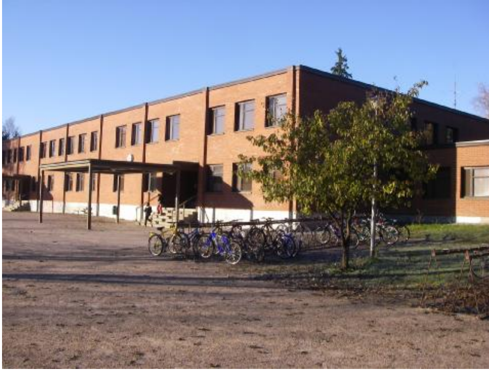
Yleiskuvaa B-siiven julkisivusta.
