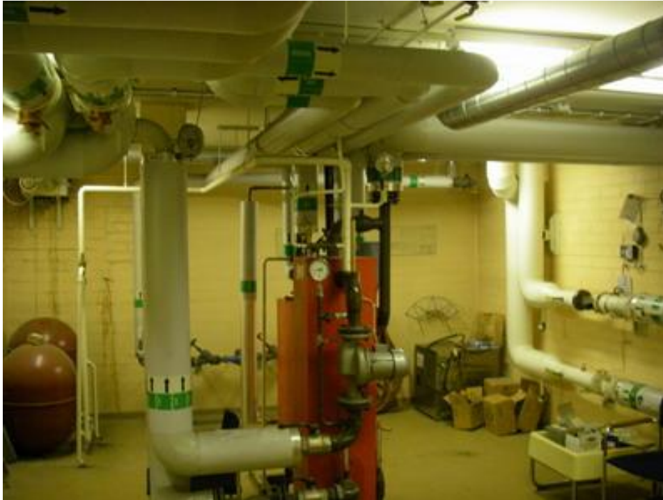
Lämmönsiirtimet tulee uusittaviksi PTS-jakson alkupuolella.
