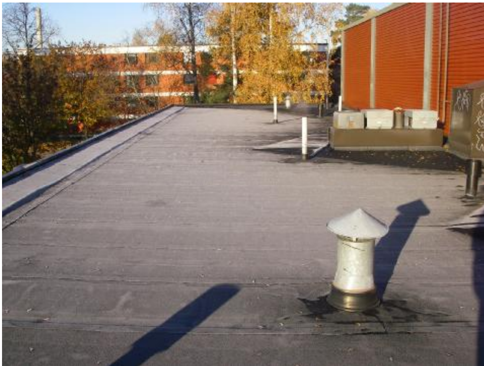
Näkymä vesikatolta. Kokonaisuutena vesikatto on kunnossa ja sillä on runsaasti käyttöikää jäljellä.
