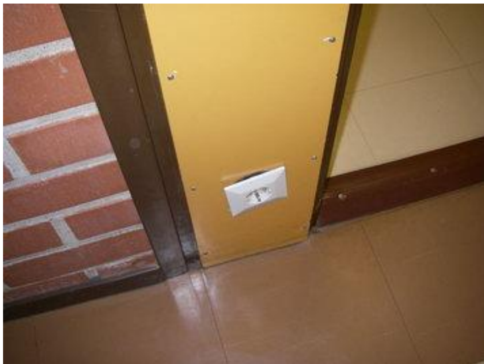
Osa pistorasioista on irronnut.
