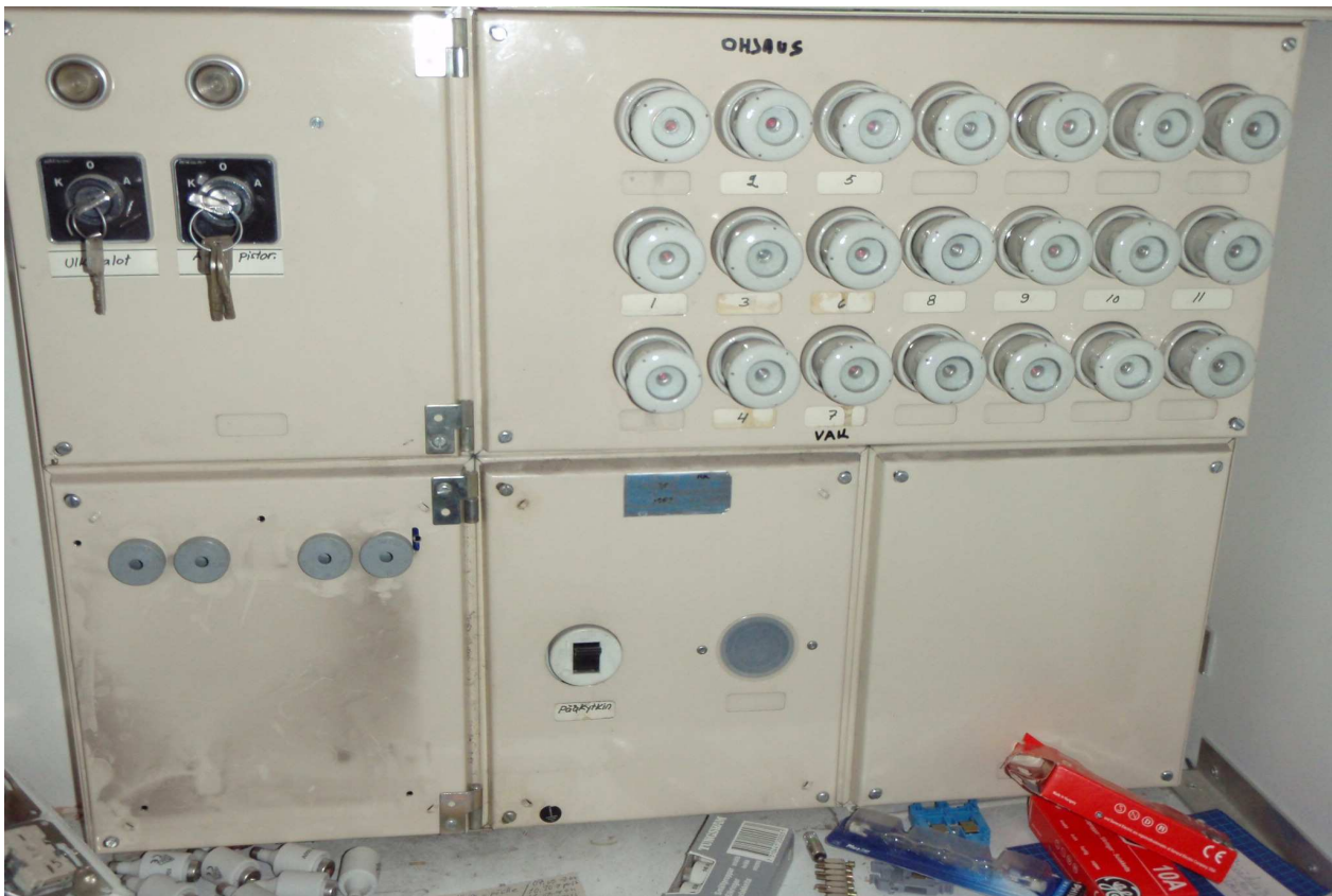
S-KUVA 3. IV- järjestelmän keskus.
