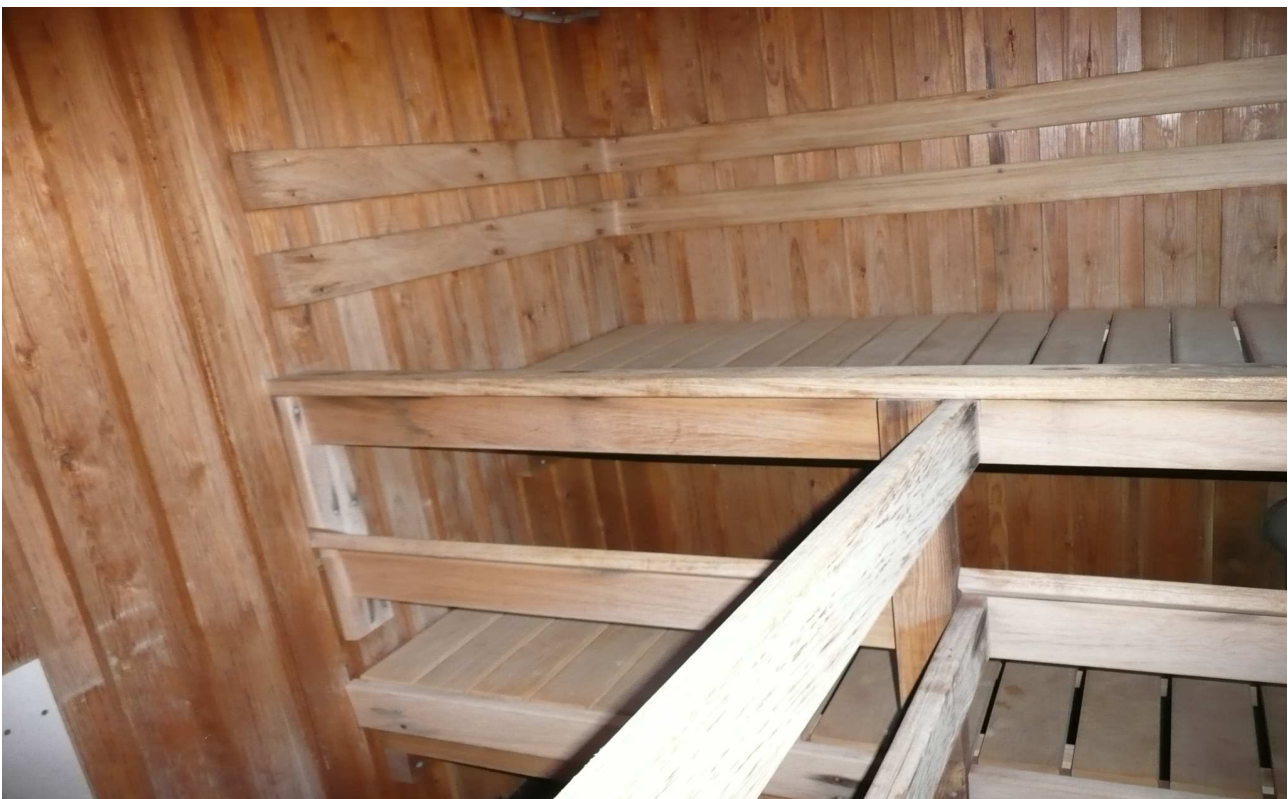
R-kuva 6. Saunan sisutus on kulunut.
