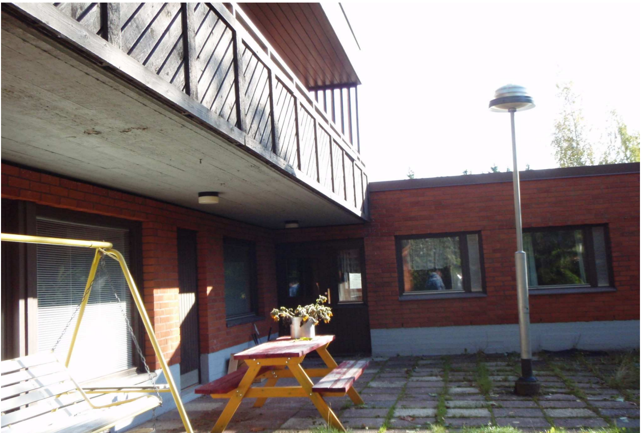
S-KUVA 2. Pylväsvalaisin ja katoksen valaistus.
